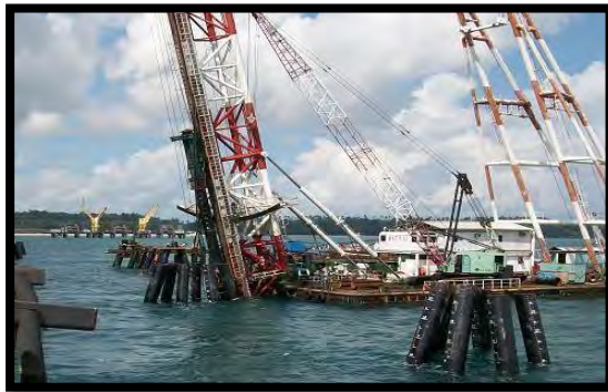
Gambar 1.3 Proses Pemancangan Tiang
