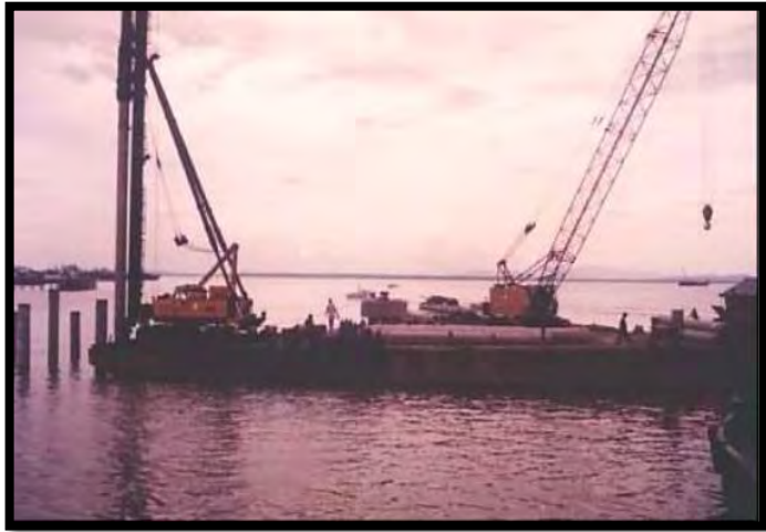
Gambar 1.1 Ponton Pancang dan Ponton Crane Pada Proses Pemancangan
