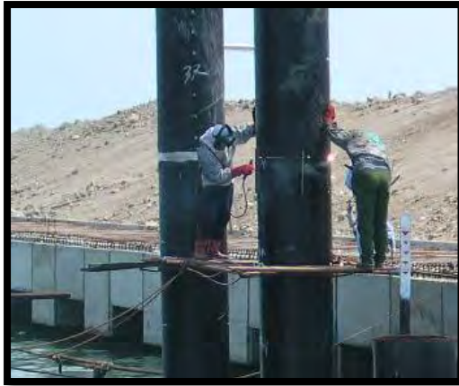
Gambar 1.4 Penyambungan Tiang Pancang
