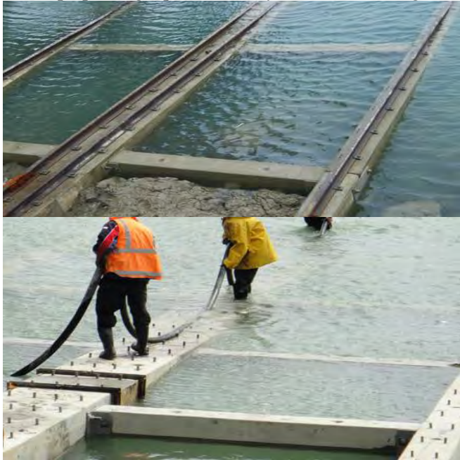
Gambar 1.10 Pemasangan Rel
