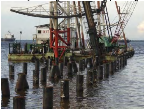
Gambar 9.7 Pemancangan Tiang Baja
