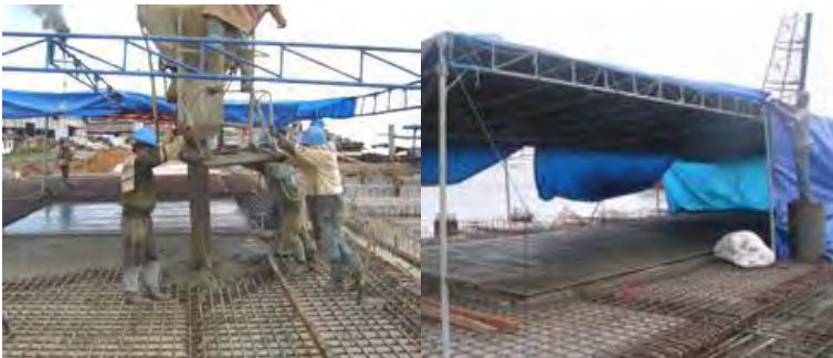
Gambar 9.8 Proses pengecoran pelat
