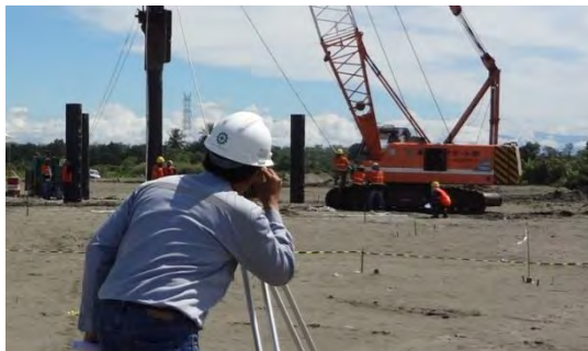
Gambar 9.5 -Pemeriksaan Posisi Tiang Pancang dengan Theodolit
