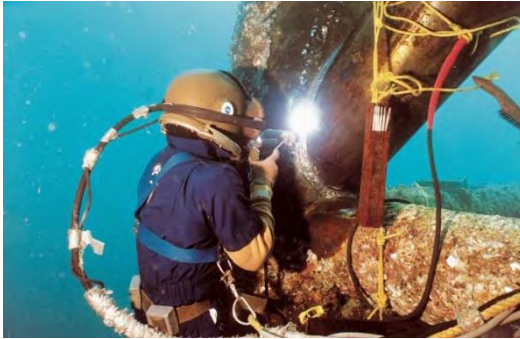
Gambar 9.6 Penyambungan antar tiang pancang baja (dilas)
