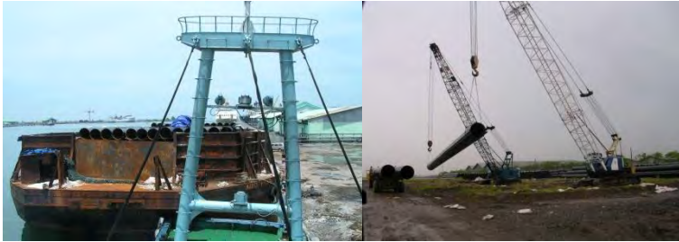
Gambar 9.4 -Pengangkutan tiang pancang menggunakan ponton
