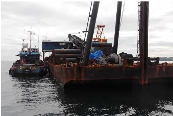
Gambar 9.3- Ponton Pancang dan Ponton Crane
