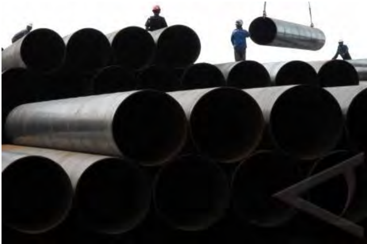
Gambar 9.2 – Pengadaan/penumpukan tiang pancang
