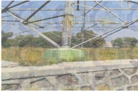
Gambar 4.8 Pondasi Tower pada T 09 (PLTU Gresik – Waru)
