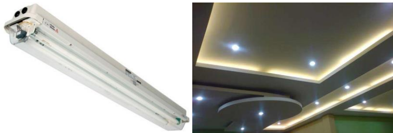
Gambar. Lampu TL dan lampu Downlight digunakan sebagai pencahayaan buatan didalam bangunan
