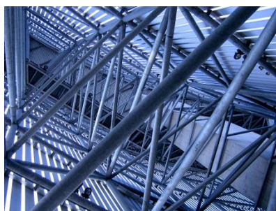
Gambar. Rangka atap konstruksi baja ringan Space Frame ditopang oleh kolom
