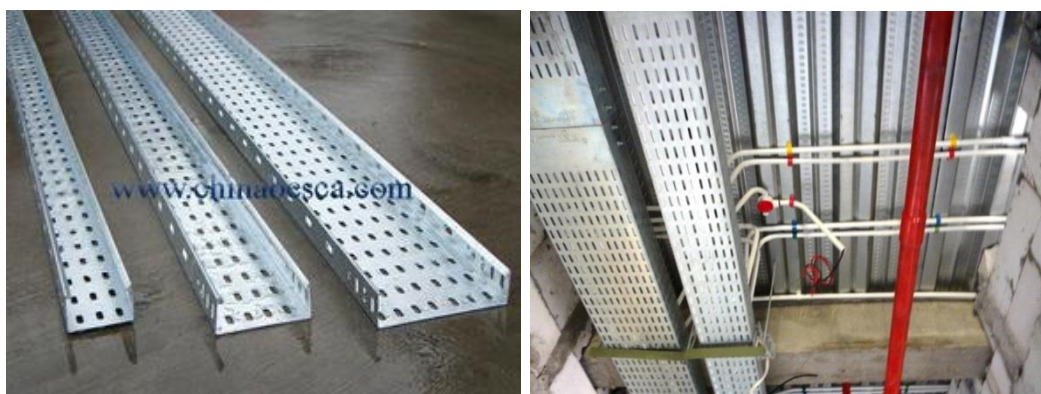
Gambar. Jalur Trey Ducting, dan jalur yang dibedakan antara arus kuat dan arus lemah
