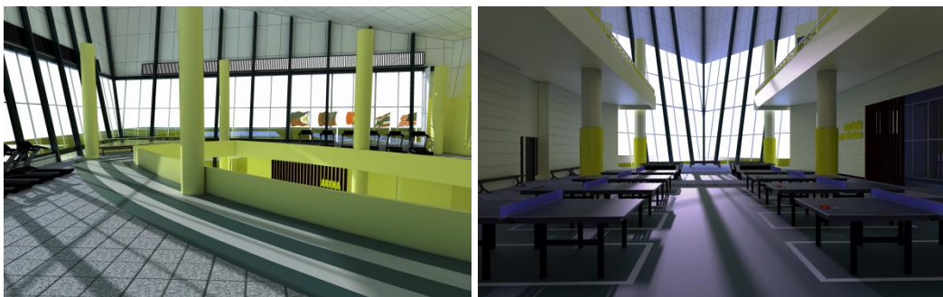
Gambar. Baja Profil yang menopang curtain wall
