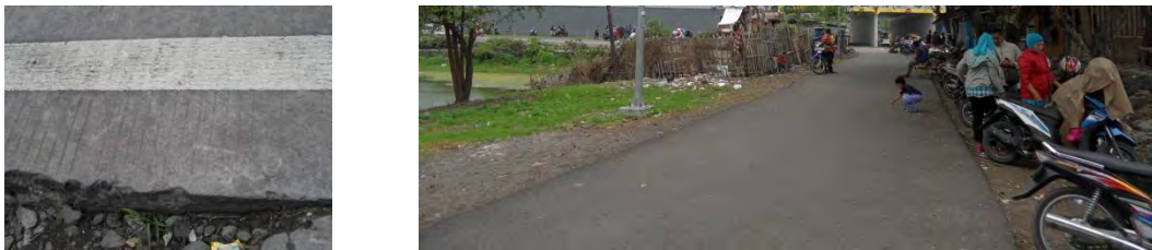
Gambar 3.4: Material jalan utama site tambak wedi dan Material jalan sekunder site tambak wedi
