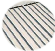
Penutup Atap Metal Sheet
