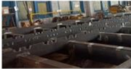
Gambar 4. 40 Proses Fit Up Support Frame Sumber : dokumen pribadi
