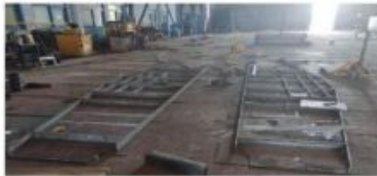
Gambar 4. 16 Proses Fit Up Sumber : dokumen pribadi
