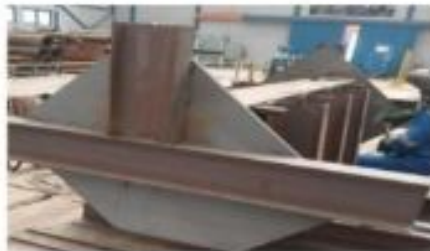
Gambar 4. 9 Intermitten Welding Sumber : dokumen pribadi
