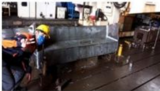
Gambar 4. 38 Feed Box setelah proses Drilling Sumber : dokumen pribadi
