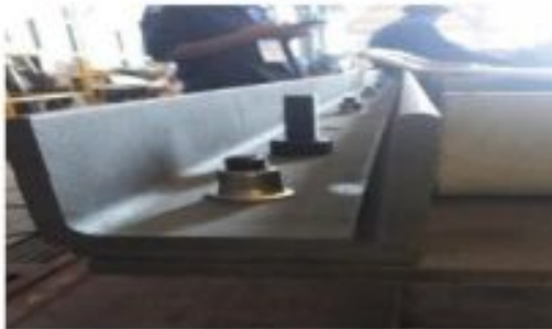
Gambar 4. 18 Proses Drilling Sumber : dokumen pribadi
