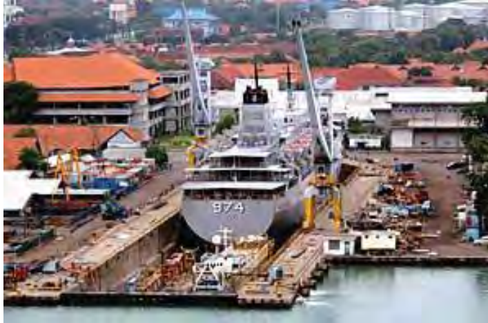
Gambar 4.3. Graving Dock kapasitas 20.000 DWT
