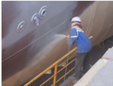
Gambar 2 Proses Pengecatan lambung kapal dengan Spray
