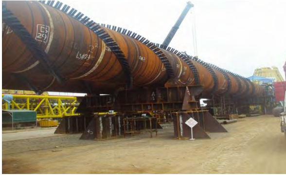
Gambar 4. 14 Helical Strike pada pipeline
