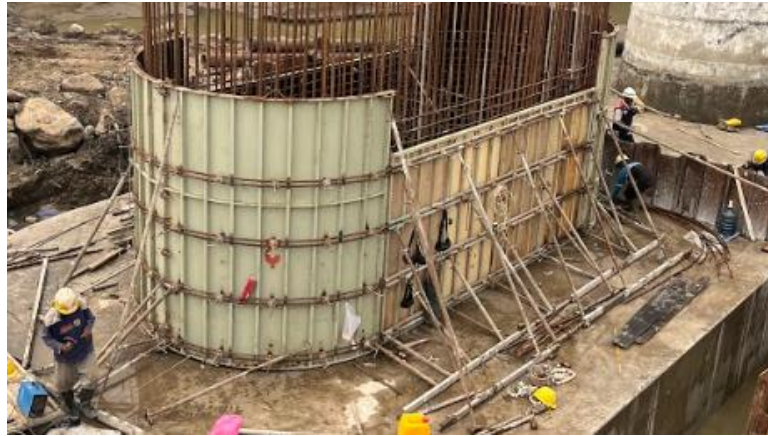
Gambar 5. 32 Pemasangan Bekisting Badan Pier P-3
