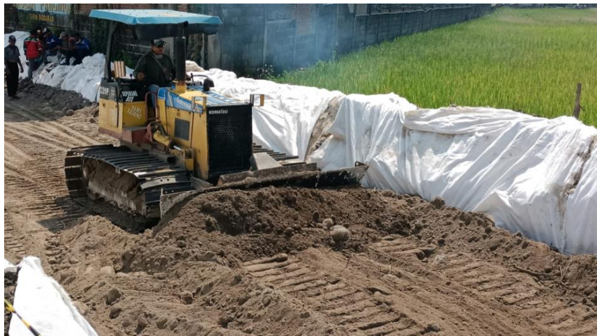
Gambar 5. 7 Perataan Material Tanah Berbutir Menggunakan Bulldozer
