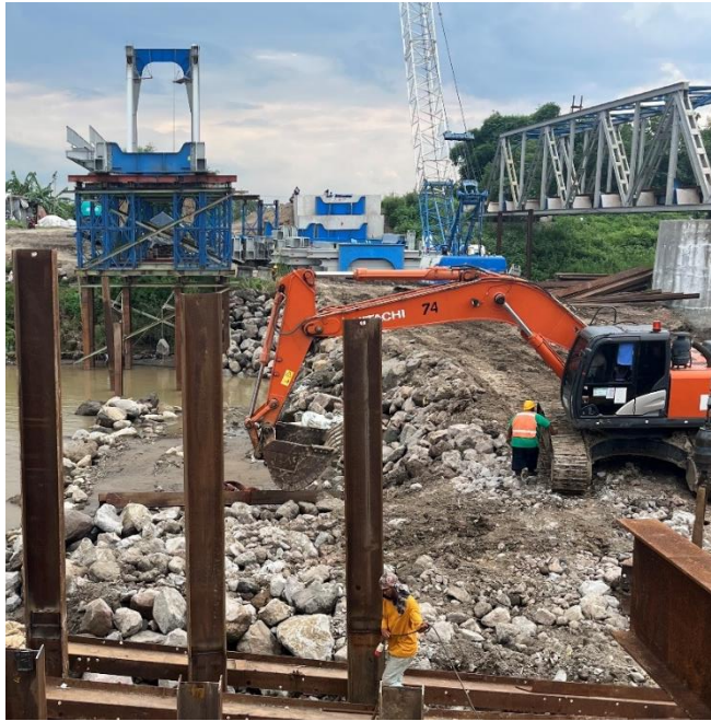
Gambar 2. 35 Timbunan Tanah sebagai Akses di Lapangan
