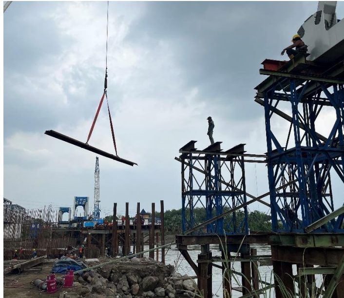
Gambar 5. 42 Pemasangan Jug Penyetelan
