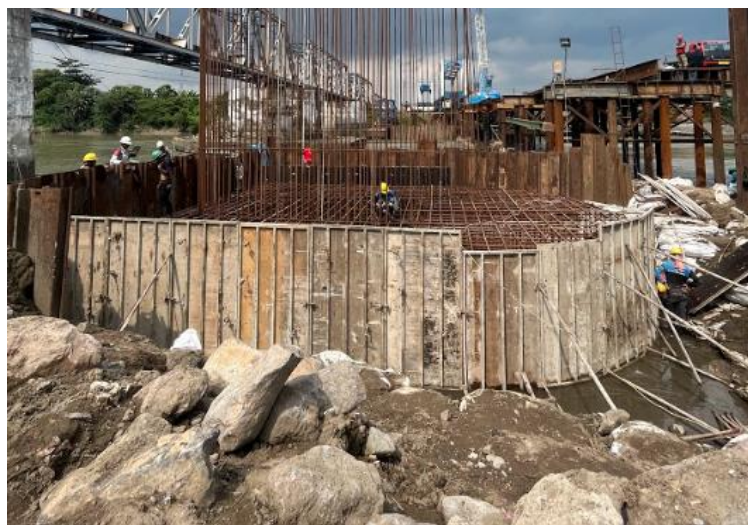
Gambar 2. 23 Pekerjaan Pemasangan Bekisting Footing Pilar 3
