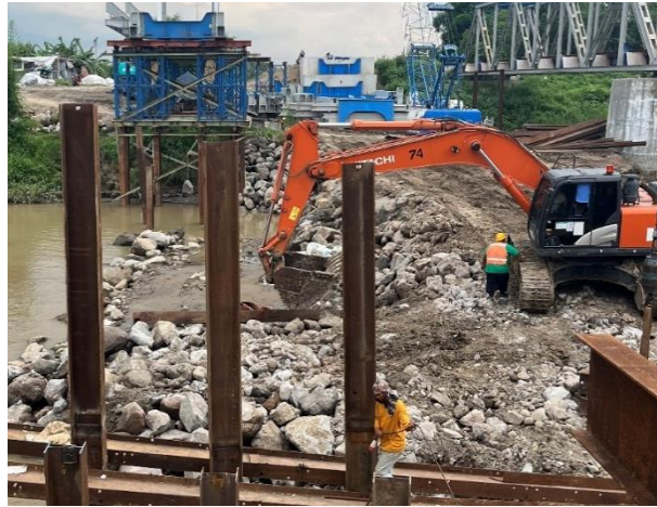
Gambar 5. 24 Pemancangan Steel Sheet Pile untuk Membendung Air
