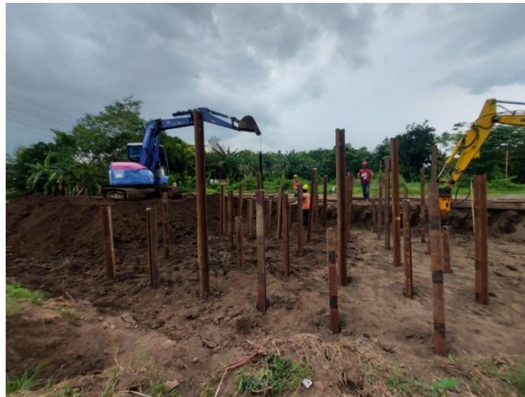
Gambar 5. 4 Kondisi Pancang Rel di Lapangan
