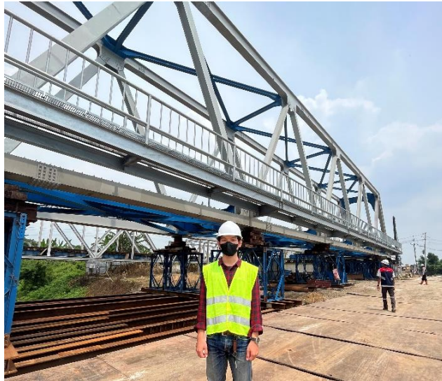
Gambar 4. 4 Pekerjaan Erection Jembatan KA dari KM. 49+000
