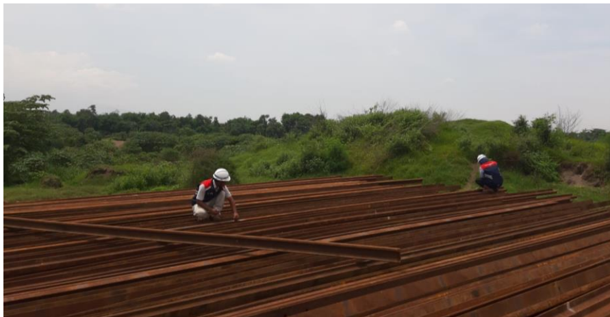
Gambar 5. 1 Pekerjaan Marking Pancang Rel untuk Perkuatan Tanah
