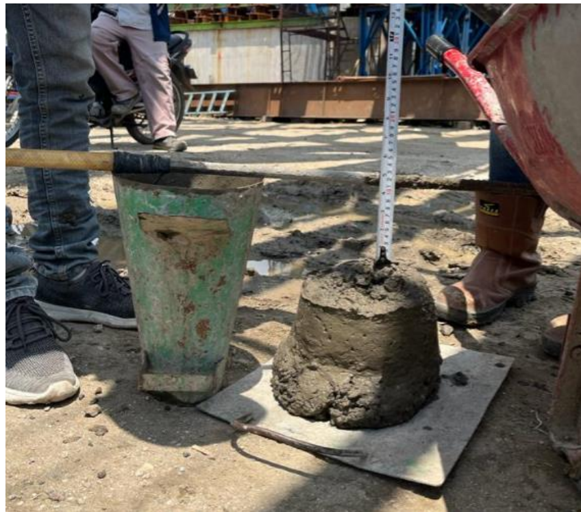
Gambar 2. 25 Uji Slump di Lapangan
