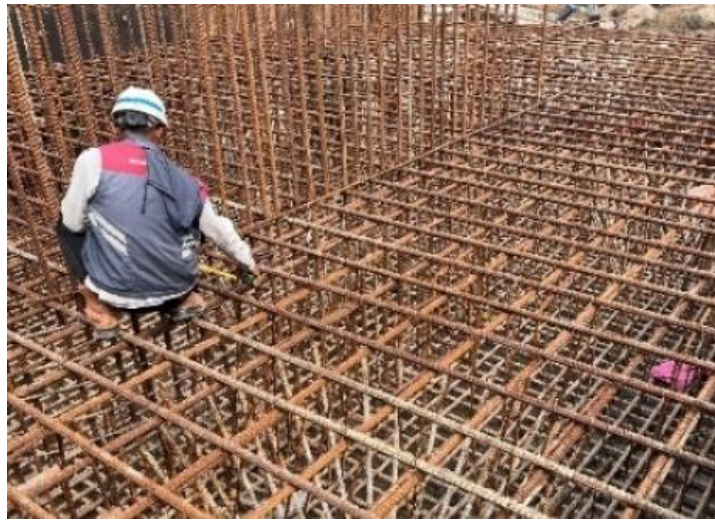
Gambar 2. 22 Pekerjaan Penulangan Footing Pilar 3
