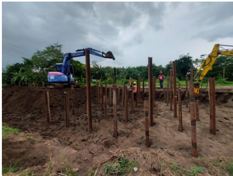
Gambar 4. 2 Pemancangan Rel Bekas sebagai Perkuatan Tanah
