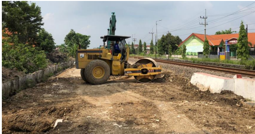
Gambar 5. 13 Pemasatan Material Tanah Timbunan
