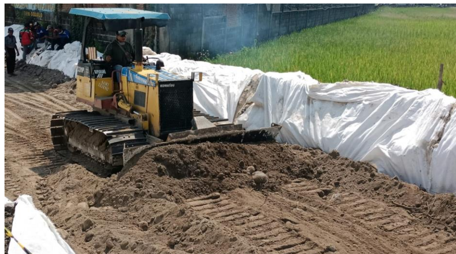
Gambar 2. 7 Pelaksanaan Pekerjaan Pekerjaan Tanah Berbutir dibungkus Geotekstil di Lapangan
