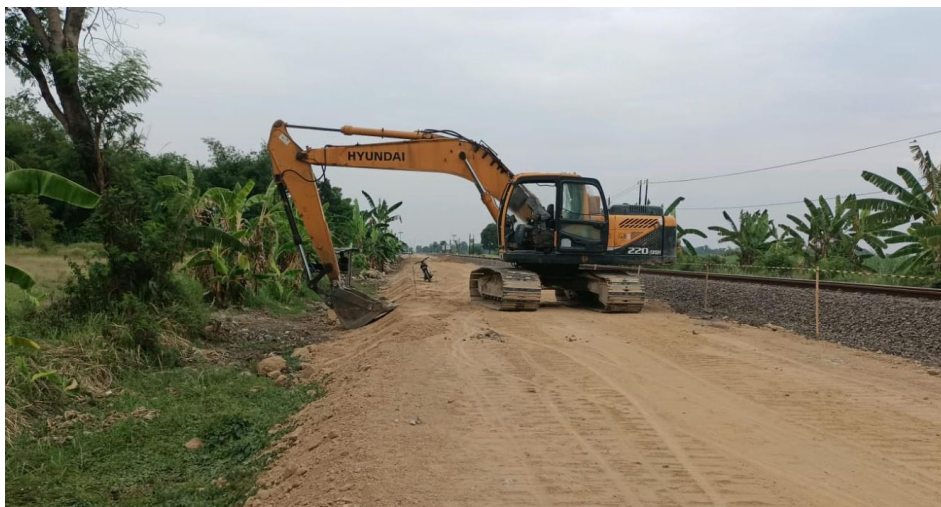
Gambar 5. 14 Penyesuaian Slope Timbunan Menggunakan Excavator
