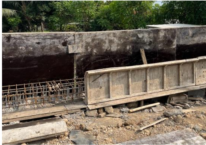
Gambar 5. 17 Penulangan dan Pemasangan Bekisting Pilecap CCSP
