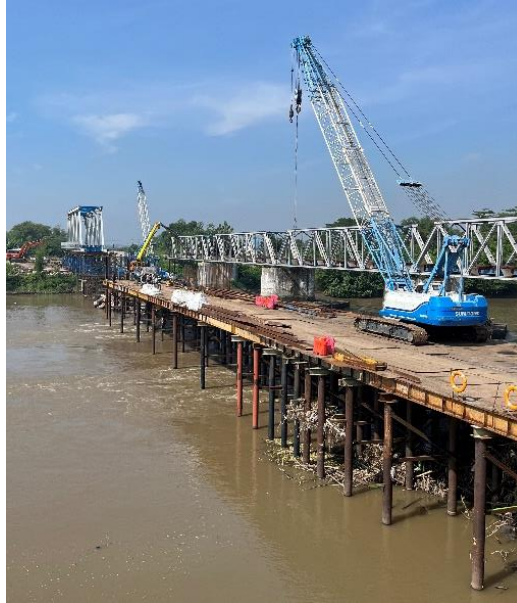
Gambar 2. 14 Foto Jembatan Akses dan Jug Penyetelan di Lapangan
