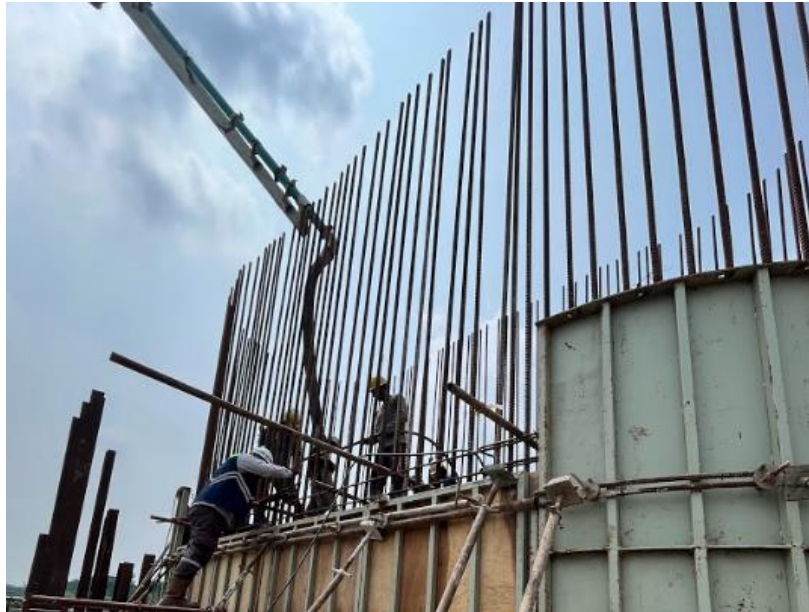
Gambar 2. 30 Proses Pengecoran Badan Pilar 3
