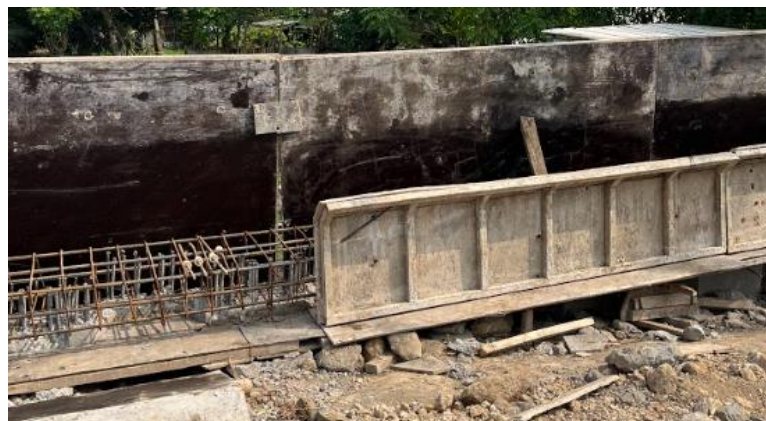
Gambar 5. 18 Pengecoran Pilecap CCSP
