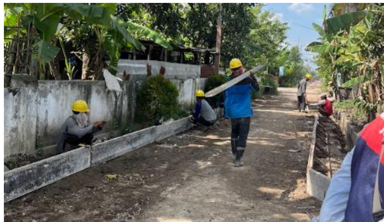
Gambar 5. 47 Pemasangan Bekisting Rigid Pavement
