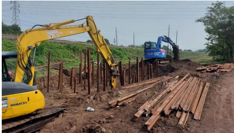
Gambar 2. 3 Proses Pemancangan Rel
