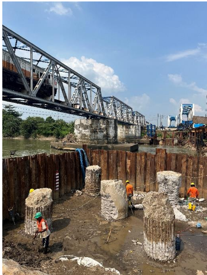
Gambar 2. 21 Proses Pembobokan Borepile Pilar 3
