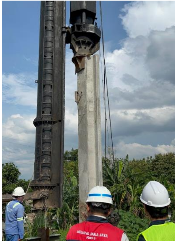
Gambar 5. 15 Pemancangan CCSP di Lapangan
