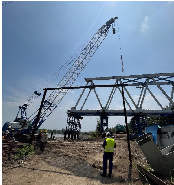
Gambar 4. 5 Pekerjaan Erection Jembatan KA dari KM. 49+250
