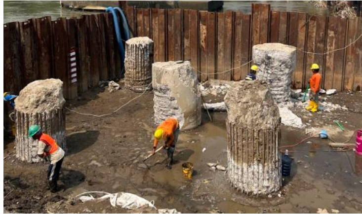
Gambar 5. 27 Pembobokan Borepile P-3
