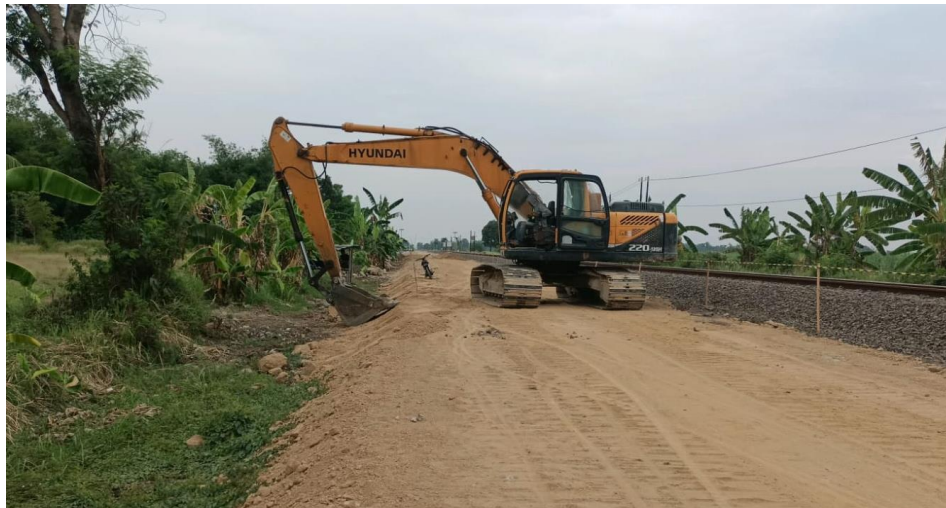
Gambar 2. 9 Pelaksanaan Pekerjaan Timbunan Tanah Pilihan di Lapangan
