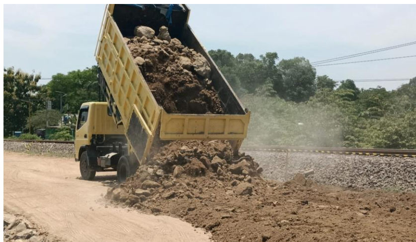
Gambar 5. 11 Mobilisasi Material Tanah Pilihan
