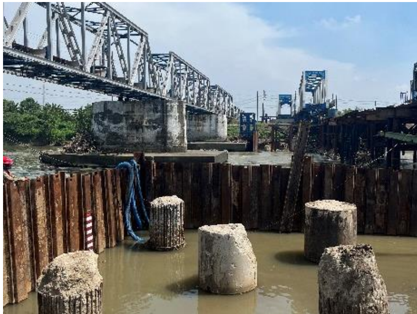
Gambar 2. 20 Proses Dewatering Pilar 3
