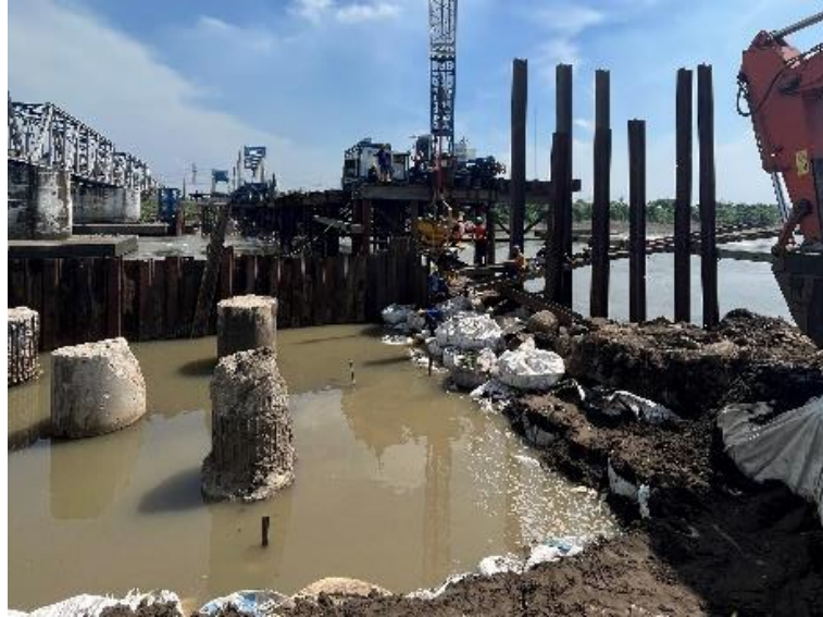
Gambar 2. 19 Pelaksanaan Pemasangan SSP
