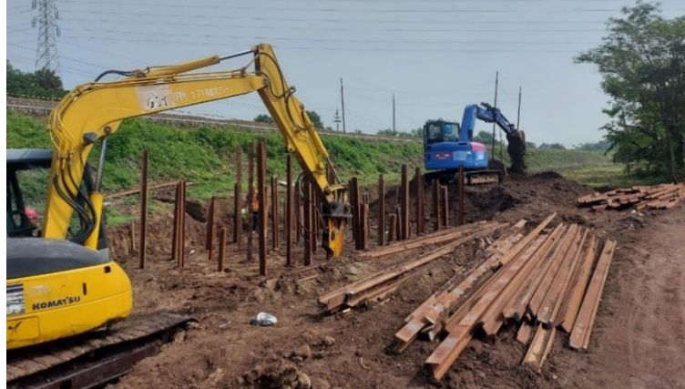
Gambar 5. 3 Pekerjaan Pemancangan Rel
