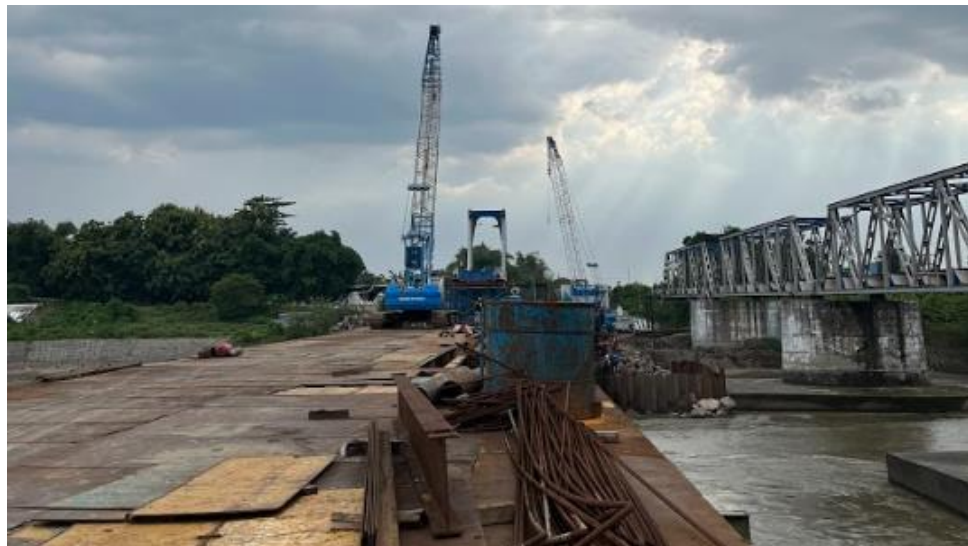
Gambar 2. 34 Jembatan Akses di Lapangan
