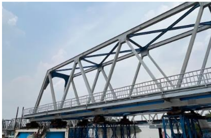
Gambar 5. 45 Kondisi Jembatan KA yang Telah Ter-erection
