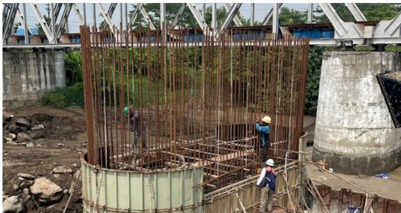
Gambar 2. 29 Proses Pemasangan Bekisting dan Pembesian Badan Pilar 3
