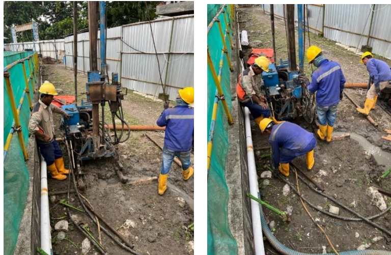
Gambar 4.5 Kondisi Eksisting Pembuatan Titik Inclinometer Baru
