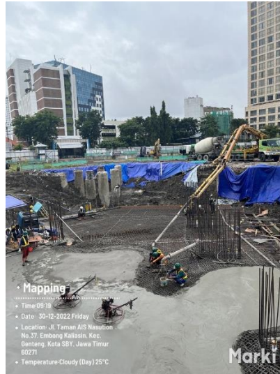
Gambar 3.64 Pengecoran dengan Concrete Pump
