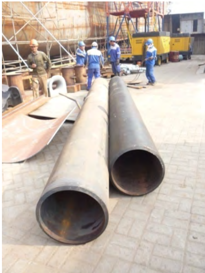
Gambar 2.20 Persiapan Instalasi Pipa di Galangan PT. DPS
