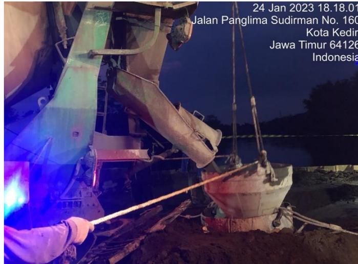
Gambar 3.17 Pelaksanaan Pengecoran *Bore pile*
