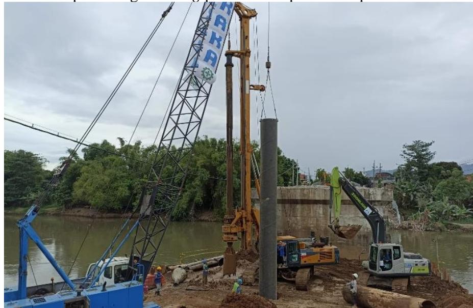
Gambar 3.10 Pemasangan *Casing Permanen*
