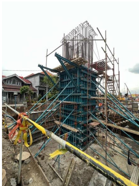
Gambar 2.25 Pemasangan Bekisting Kolom Pier
