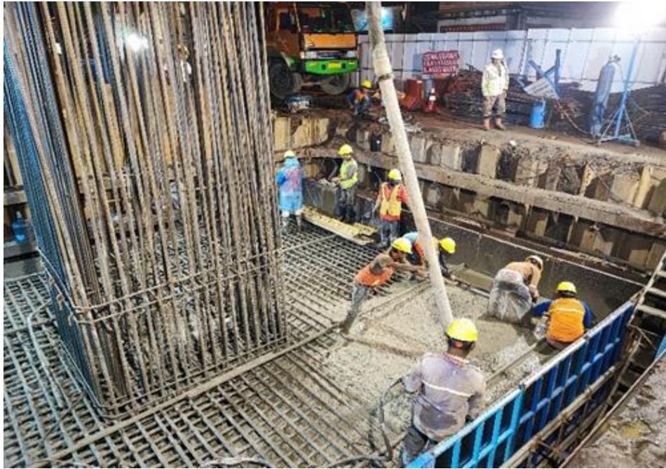
Gambar 2.20 Pekerjaan Pengecoran menggunakan Concrete Pump
