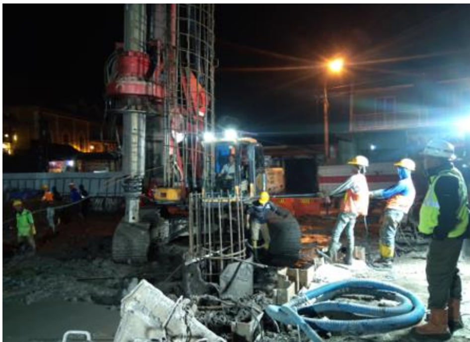
Gambar 2.13 Instalasi Pembesian Borepile
