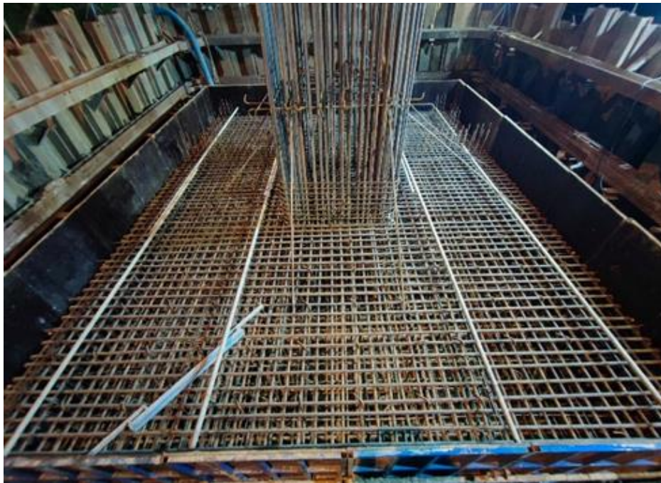
Gambar 2.19 Pekerjaan Pembesian Pile Cap
