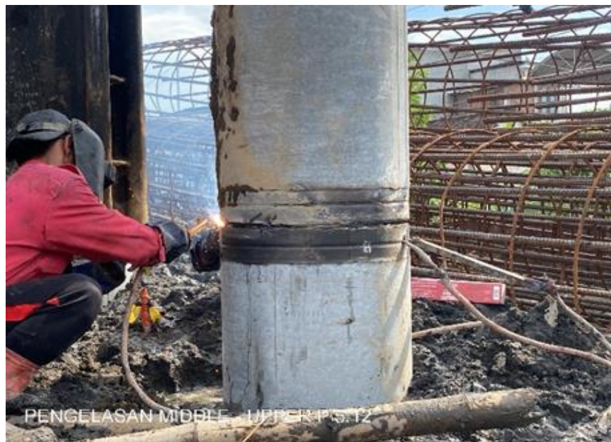
Gambar 2.8 Pengelasan Bagian Tengah – Atas Tiang Pancang
