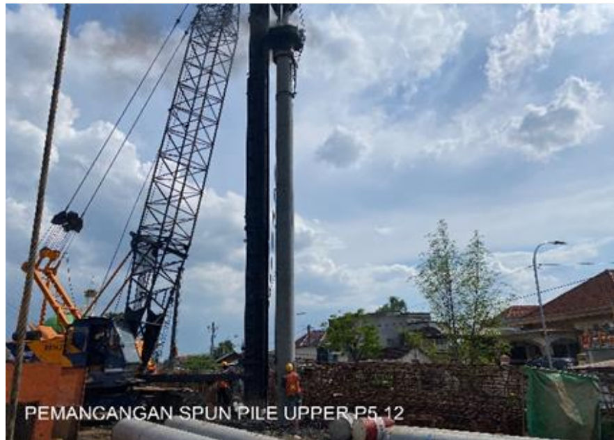
Gambar 2.9 Pemancangan Atas Tiang Pancang
