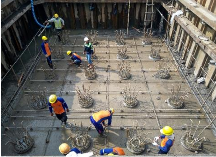
Gambar 2.18 Pekerjaan Lantai Kerja
