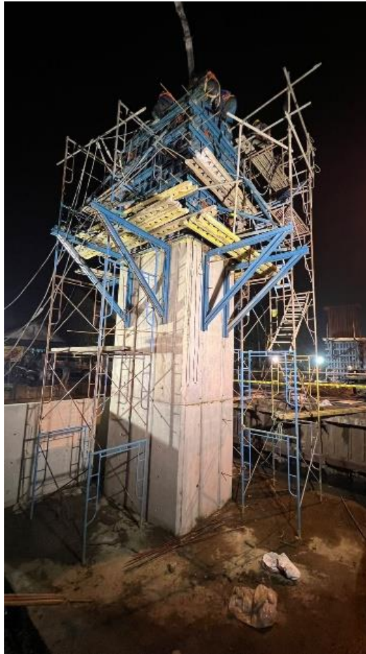
Gambar 2.26 Pengecoran Kolom Pier
