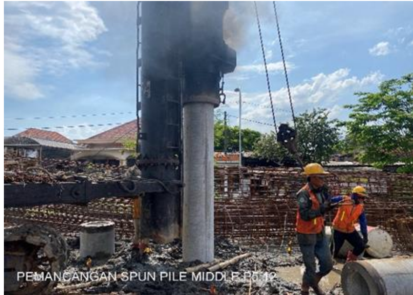
Gambar 2.7 Pemancangan Bagian Tengah Tiang Pancang
