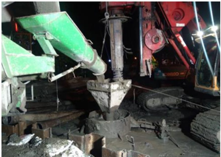
Gambar 2.15 Pengecoran dengan Tremie
