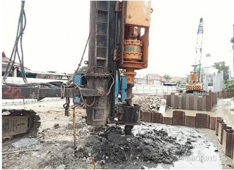
Gambar 2.5 Pemancangan Bagian Bawah Tiang Pancang
