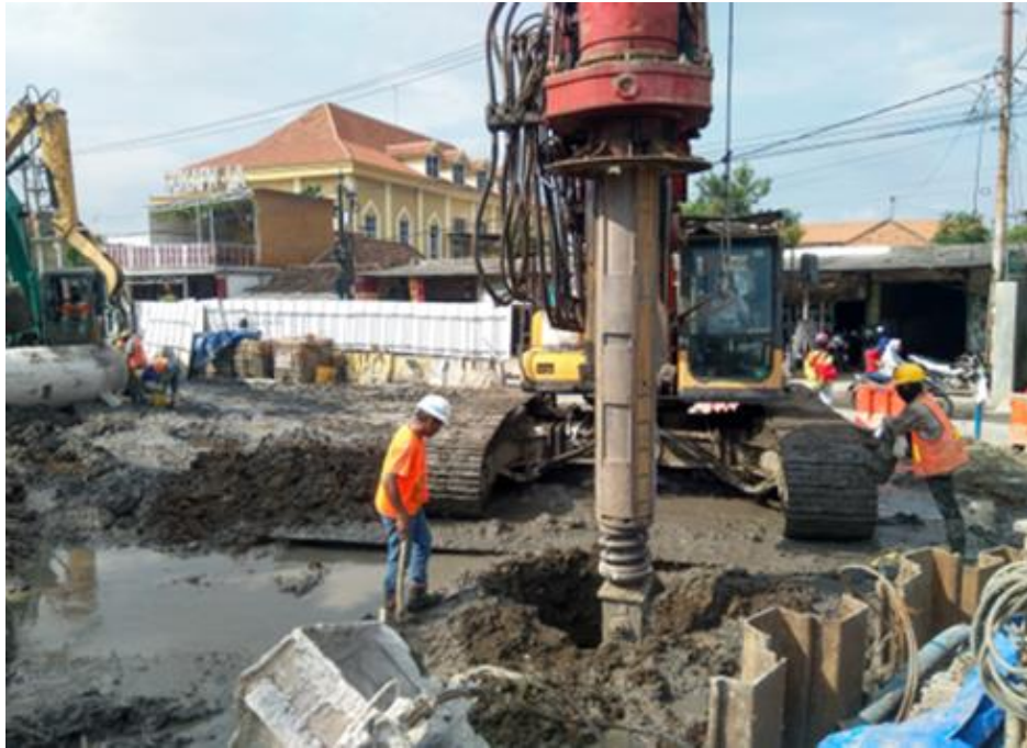
Gambar 2.12 Pengeboran Awal Bored Pile
