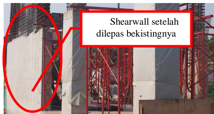
Gambar 4.45 Hasil Pengecoran Shearwall Setelah Bekisting Dilepas
