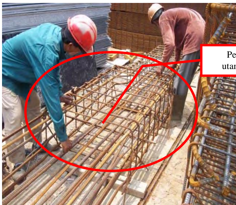
Gambar 4.4 Pekerjaan Pembesian Utama dan Senggang pada Kolom
