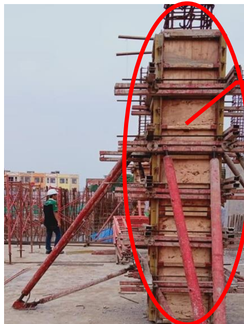
Gambar 4.8 Bekisting Kolom dan Inspeksi Quality Control
