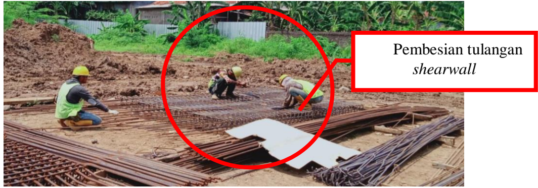
Gambar 4.37 Pekerjaan Pembesian Tulangan Utama dan Sengkang Shearwall
