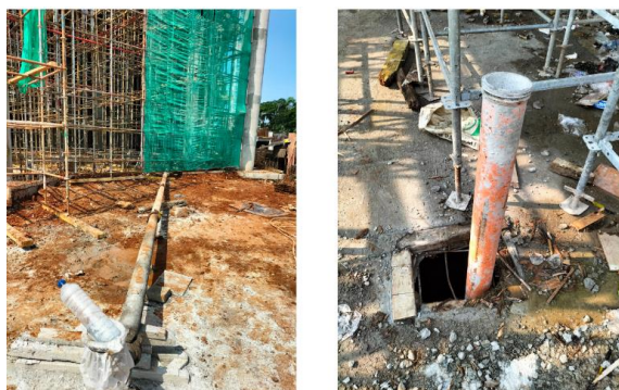
Gambar 4.49 Pipa Pengecoran untuk Lantai Atas
