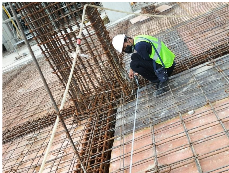
Gambar 4.47 Pengukuran Panjang Bentang Balok
