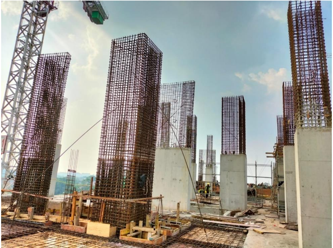
Gambar 3.1 Pelurusan Kolom yang Miring dengan Besi Penyangga
