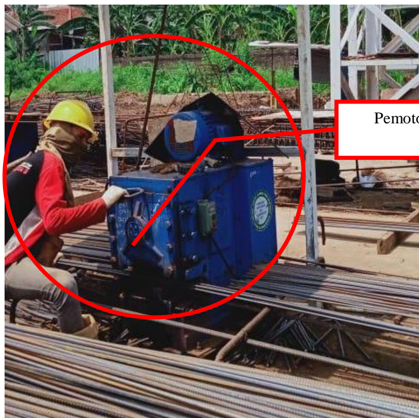
Gambar 4.3 Pekerjaan Pemotongan Besi Tulangan Kolom
