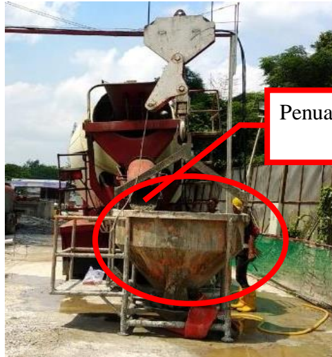
Gambar 4.43 Penuangan Beton Segar ke Concrete Bucket untuk Pengecoran Shearwall
