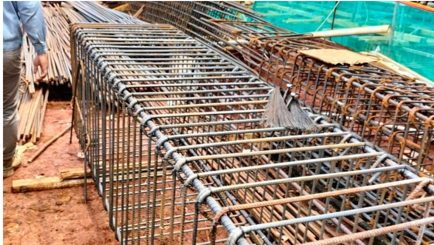
Gambar 4.5 Tulangan Kolom Selesai Difabrikasi
