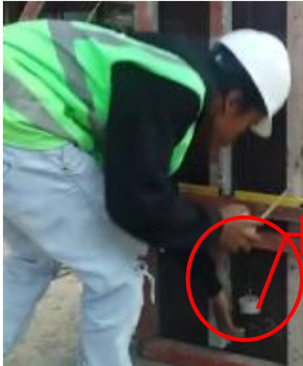
Gambar 4.42 Pengecekan Vertikalitas Shearwall dengan Unting-Unting
