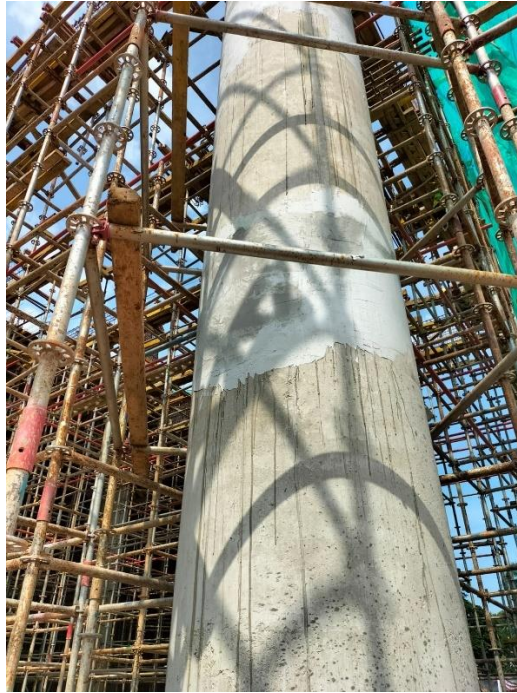
Gambar 4.50 Grouting Kolom dengan Sika
