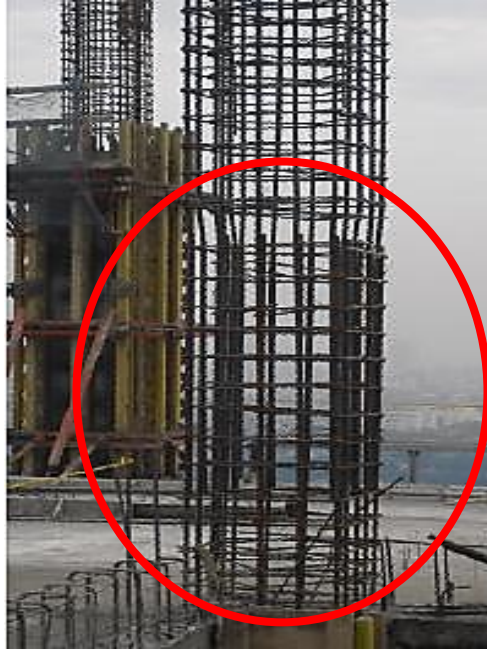
Gambar 4.7 Sambungan Tulangan Kolom
