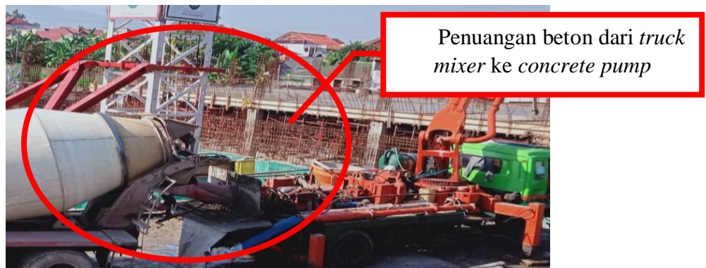
Gambar 4.28 Penuangan Beton Segar ke Concrete Pump
