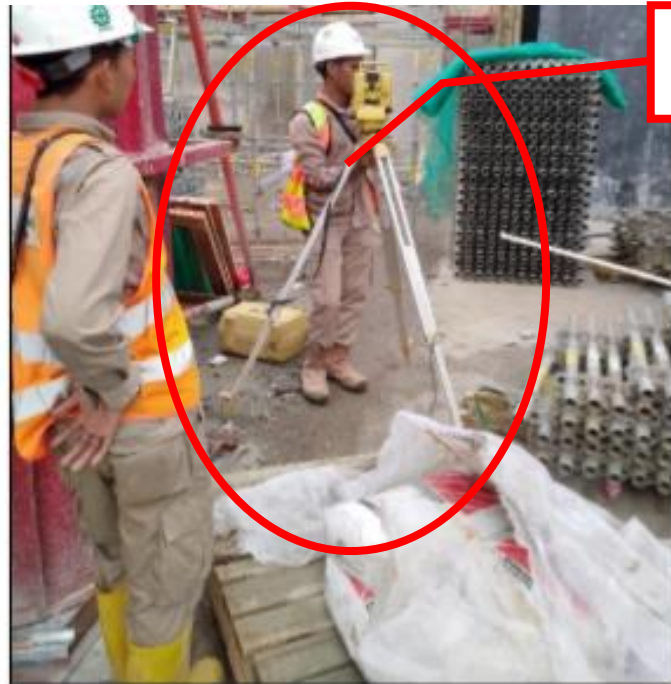
Gambar 4.2 Marking As Kolom dengan Total Station
