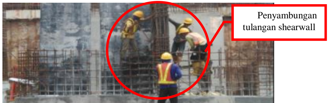
Gambar 4.38 Sambungan Tulangan Shearwall
