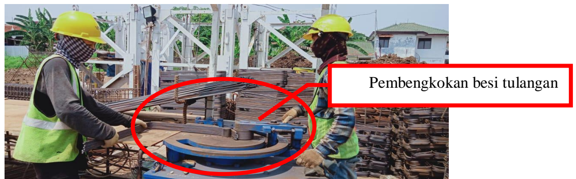
Gambar 4.21 Pembengkokan Tulangan Balok dan Pelat
