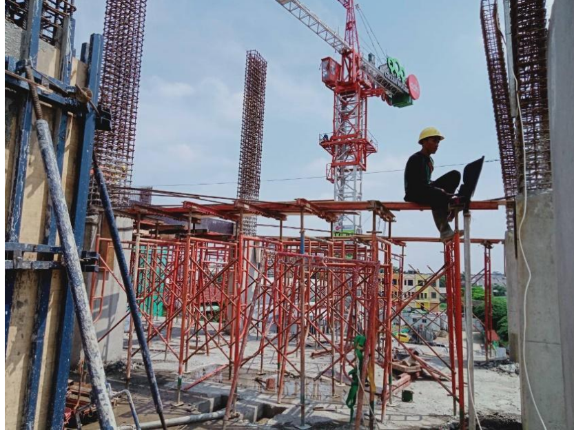
Gambar 4.18 Pembuatan Bekisting Balok pada Lantai Ground Zona 1
