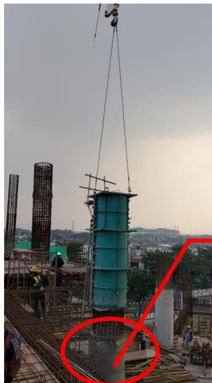
Gambar 4.13 Pelepasan Bekisting Kolom
