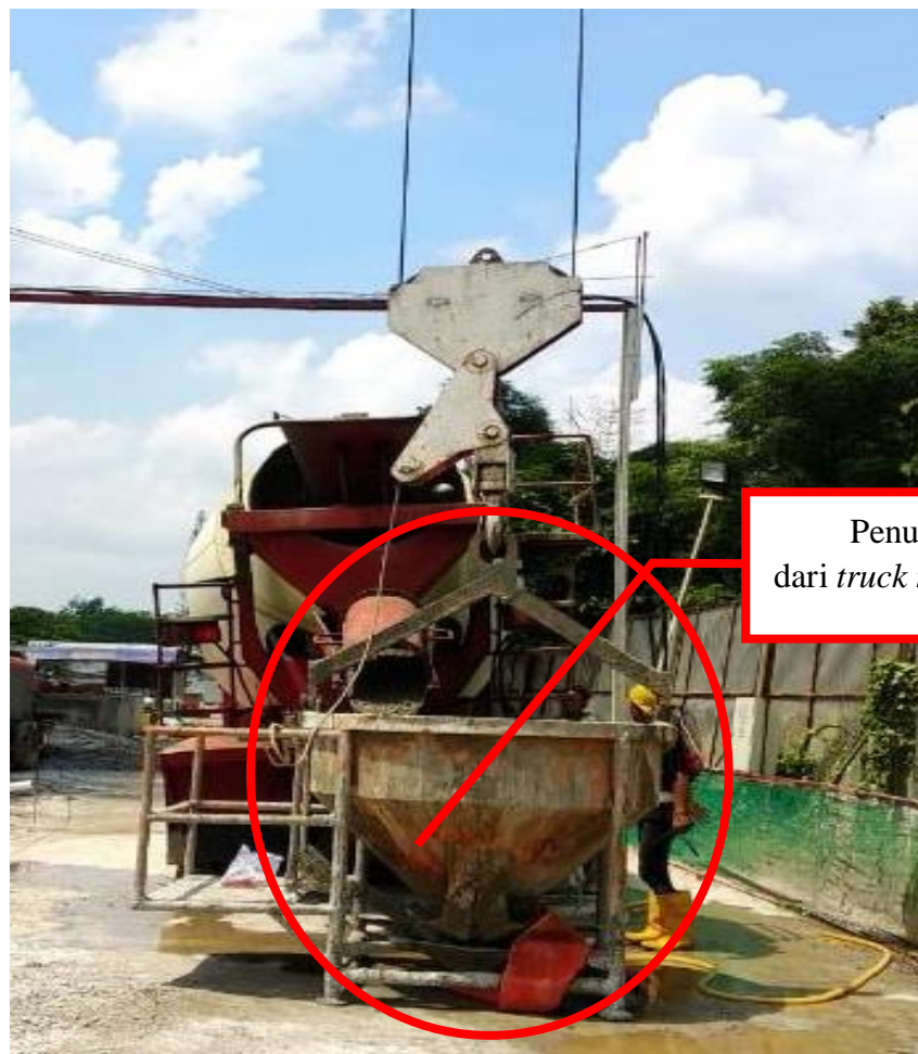
Gambar 4.11 Penuangan Beton Segar ke Concrete Bucket untuk Pengecoran Kolom
