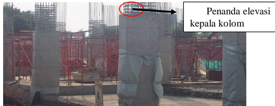
Gambar 4.15 Marking Elevasi pada Kepala Kolom
