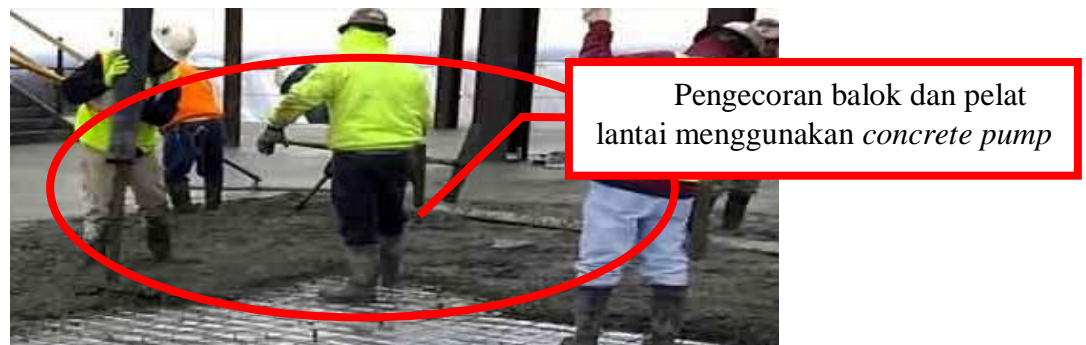
Gambar 4.29 Pengecoran Balok dan Pelat Lantai
