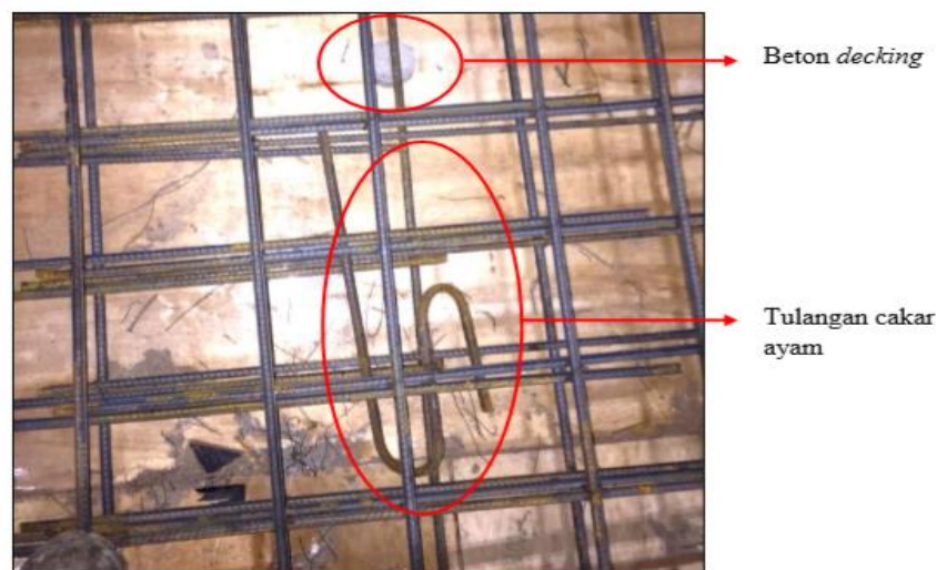
Gambar 4.26 Pemasangan Tulangan Cakar Ayam dan Beton Decking
