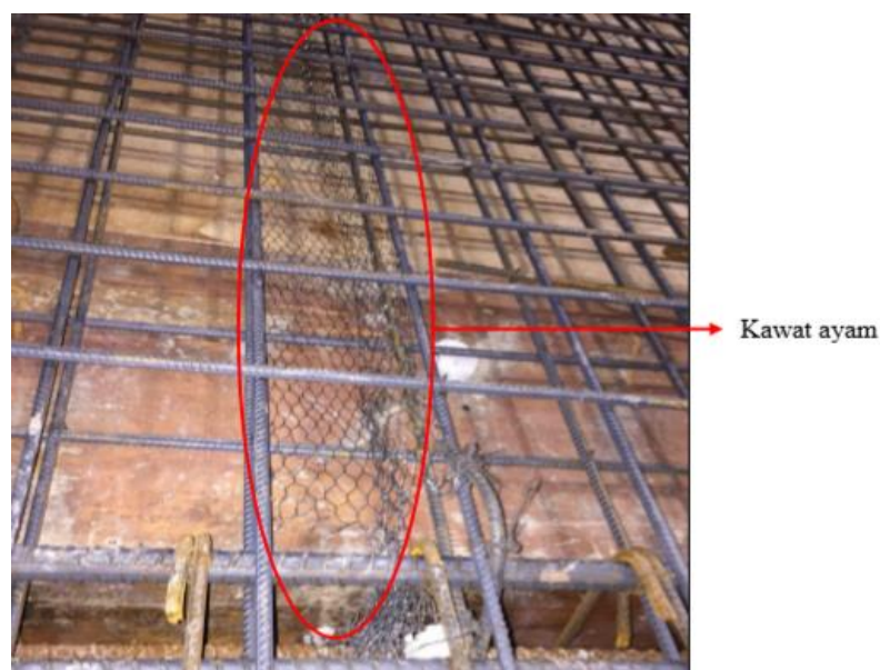
Gambar 4.27 Pemasangan Kawat Ayam pada Daerah Stop Cor
