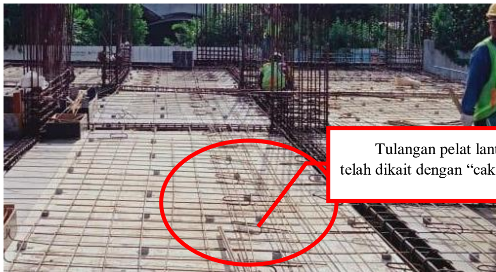
Gambar 4.24 Pemasangan Tulangan Bawah Pelat Lantai Konvensional
