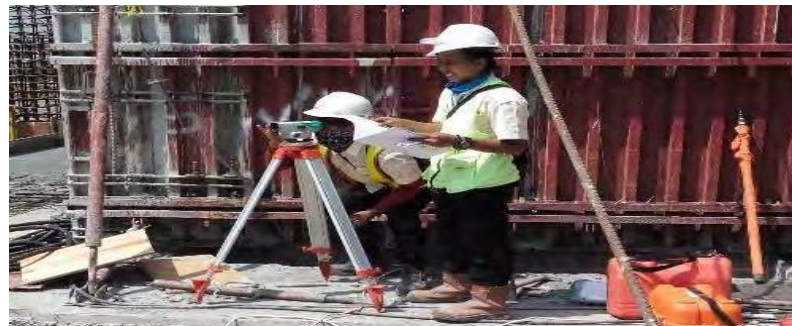
Gambar 4.16 Pengukuran Elevasi Lantai
