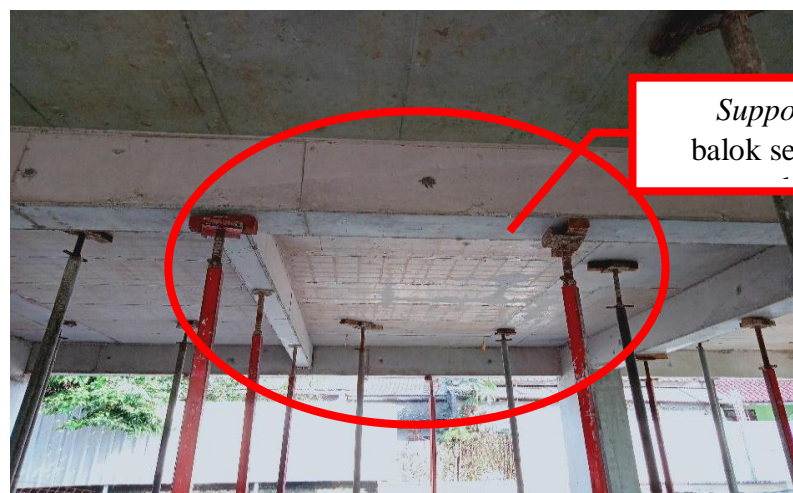
Gambar 4.32 Pelepasan Bekisting Balok dan Supporting pada Balok dan Pelat
