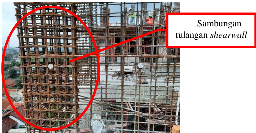
Gambar 4.39 Shearwall yang telah dipasang
