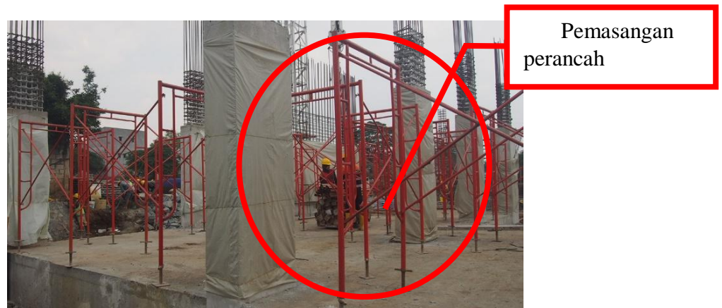
Gambar 4.17 Pemasangan Perancah untuk Balok dan Pelat
