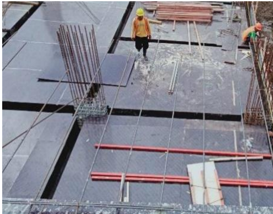
Gambar 4.19 Pembuatan Bekisting Pelat Lantai pada Lantai Lower Ground Zona 3
