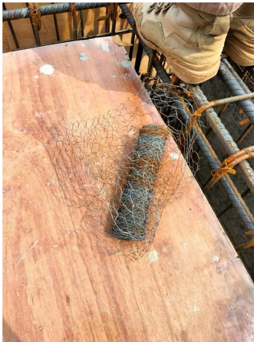
Gambar 4.51 Kawat Ayam untuk Sambungan Pengecoran
