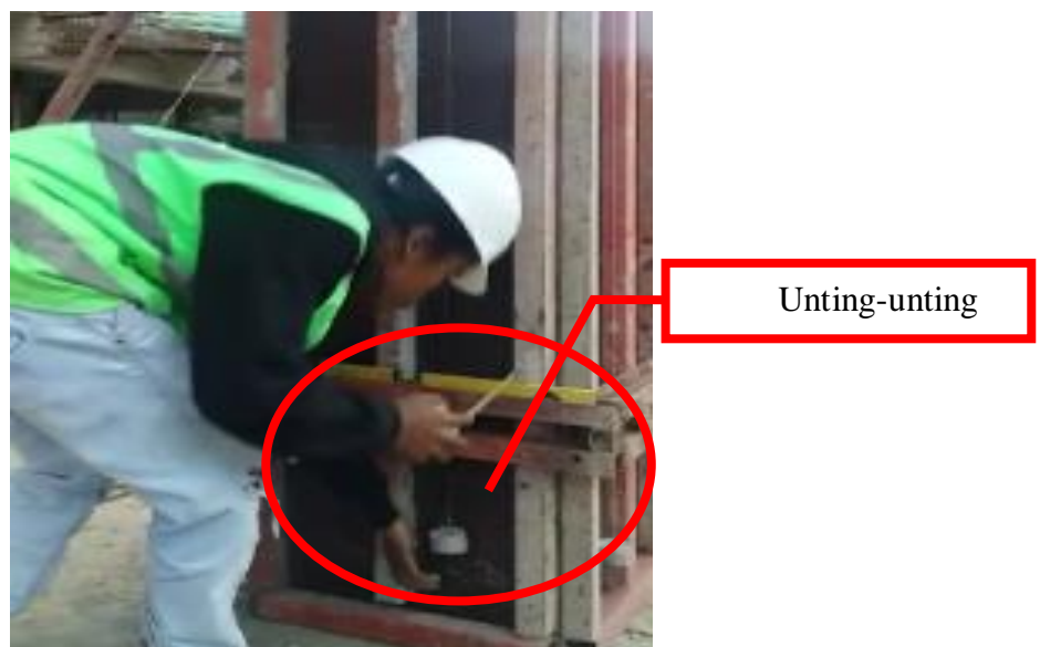
Gambar 4.10 Pengecekan Vertikalitas Kolom dengan Unting-Unting
