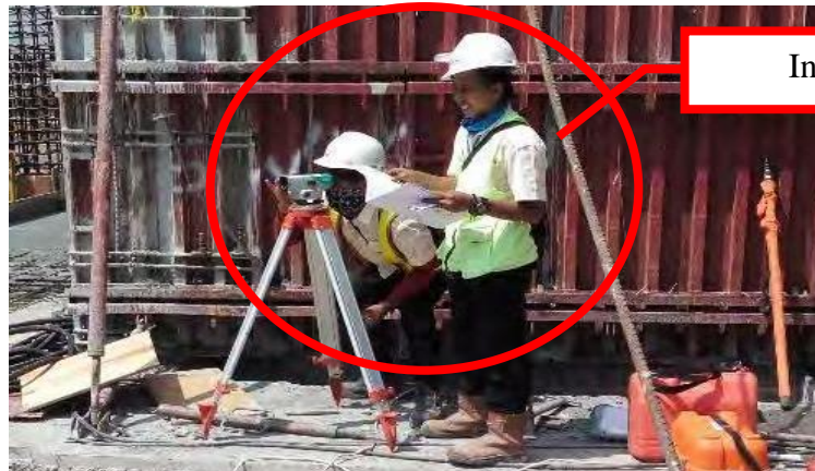
Gambar 4.31 Pemeriksaan Level Lantai Menggunakan Waterpass
