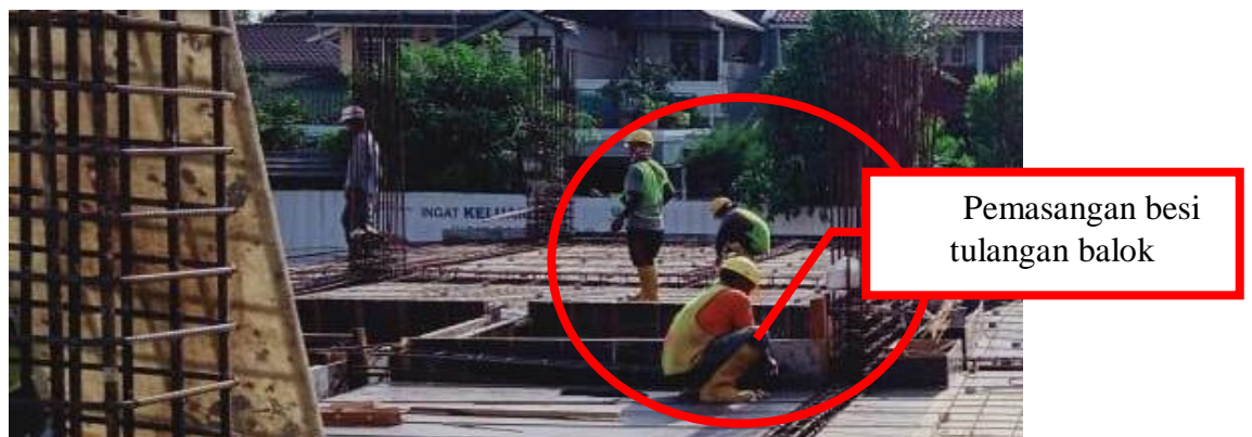
Gambar 4.22 Pemasangan Tulangan Utama dan Sengkang pada Balok Lantai
