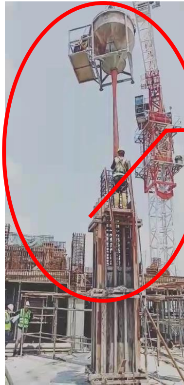
Gambar 4.12 Pengecoran Kolom Lantai dan Penggetaran dengan Concrete Vibrator
