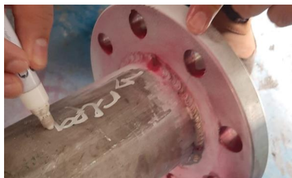
Gambar 4. 36 Proses Inspection ( Sumber : Dokumentasi Pribadi )
