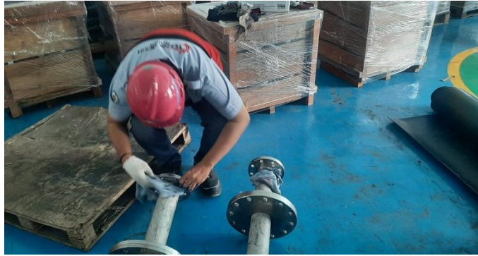
Gambar 4. 37 Proses Cleaning ( Sumber : Dokumentasi Pribadi )
