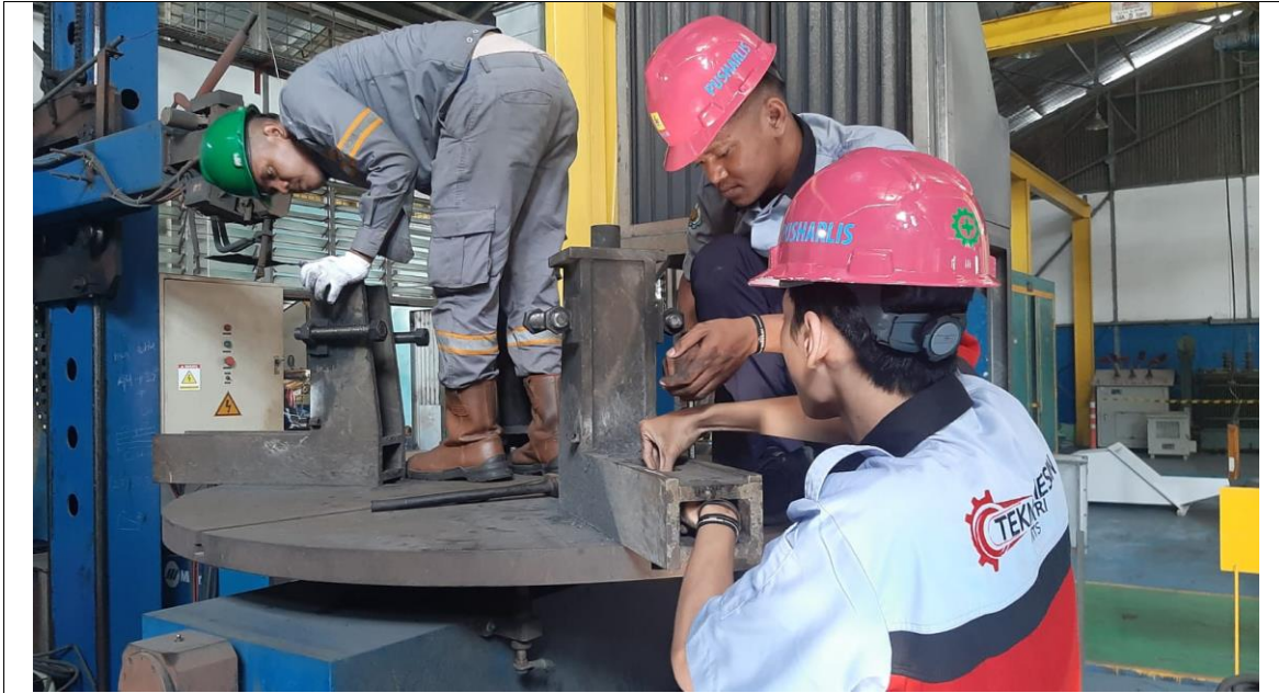
Setting Dudukan untuk proses Grinding Roll
