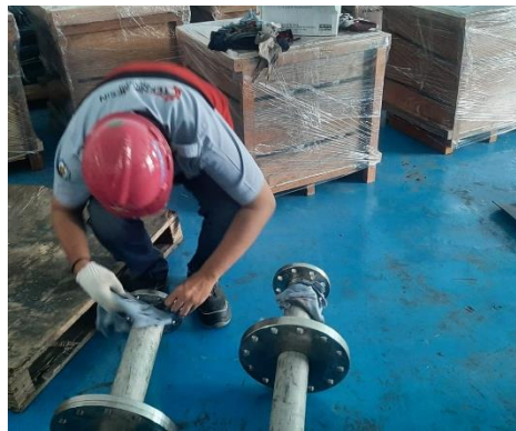
Gambar 4. 28 Proses Surface Preparation dan Pre Cleaning ( Sumber : Dokumentasi Pribadi )
