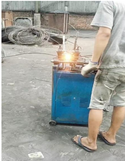
Gambar 4.15 Proses penyambungan wire rod
