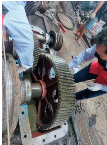
Gambar 4.58 Proses Maintenance (Pergantian Bearing) pada Motor
