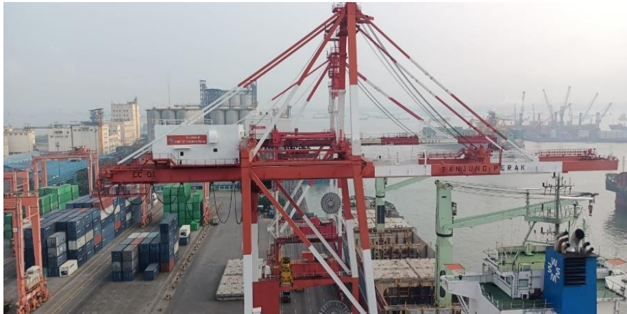
Gambar 4. 16 Container Crane 01 di Pelabuhan Nilam PTBIMA
