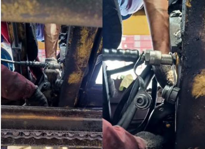
Pemasangan Rubber Mounting pada motor Spreader Container Crane 04
