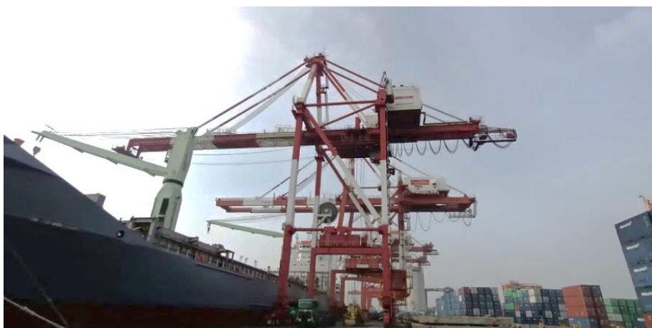
Gambar 4. 17 Container Crane 03 di Pelabuhan Nilam PTBIMA
