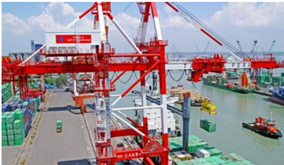
Gambar 4. 19 Container Crane 04 di Pelabuhan Nilam (Sumber : Dokumen Pribadi)
