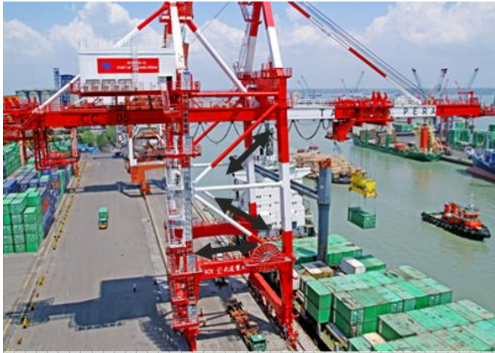
Gambar 4. 36 Cross Beam dan Portal Beam Pada CC 05
