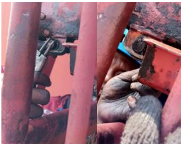
Perbaikan dan pemasangan Seal dan roller main lift bagian kanan pada Container Crane 01
