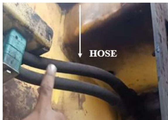
Gambar 4. 82 Hose menuju Teleskopik dari Directional Control Valve (Sumber : Dokumen Pribadi)
