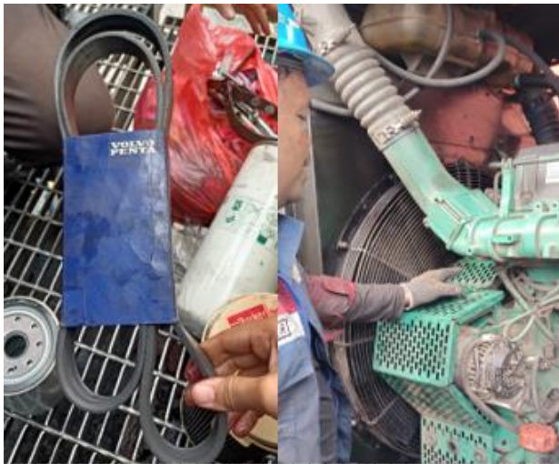
Pergantian dan pemasangan van belt mesin diesel volvo penta pada RTG
