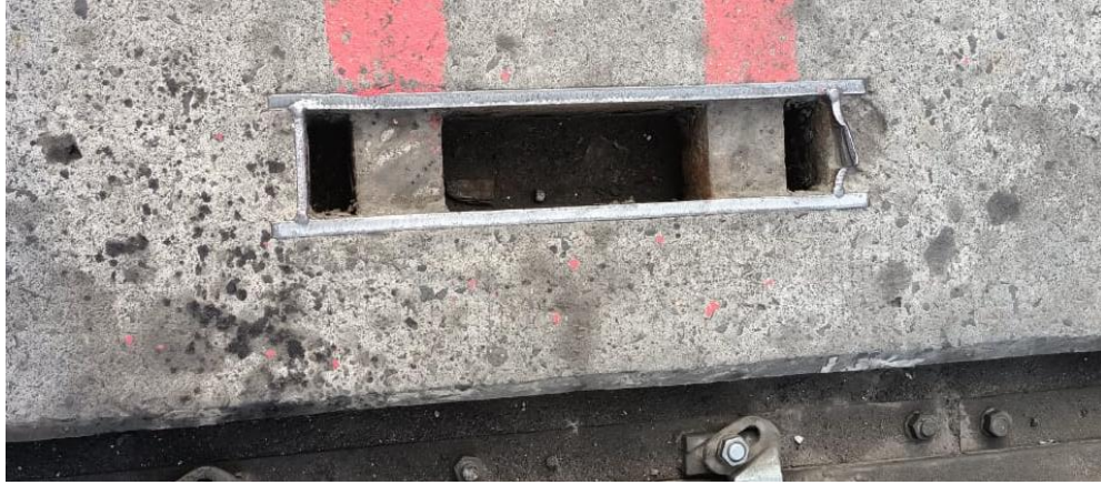
Gambar 4. 39 anchor pada container crane
