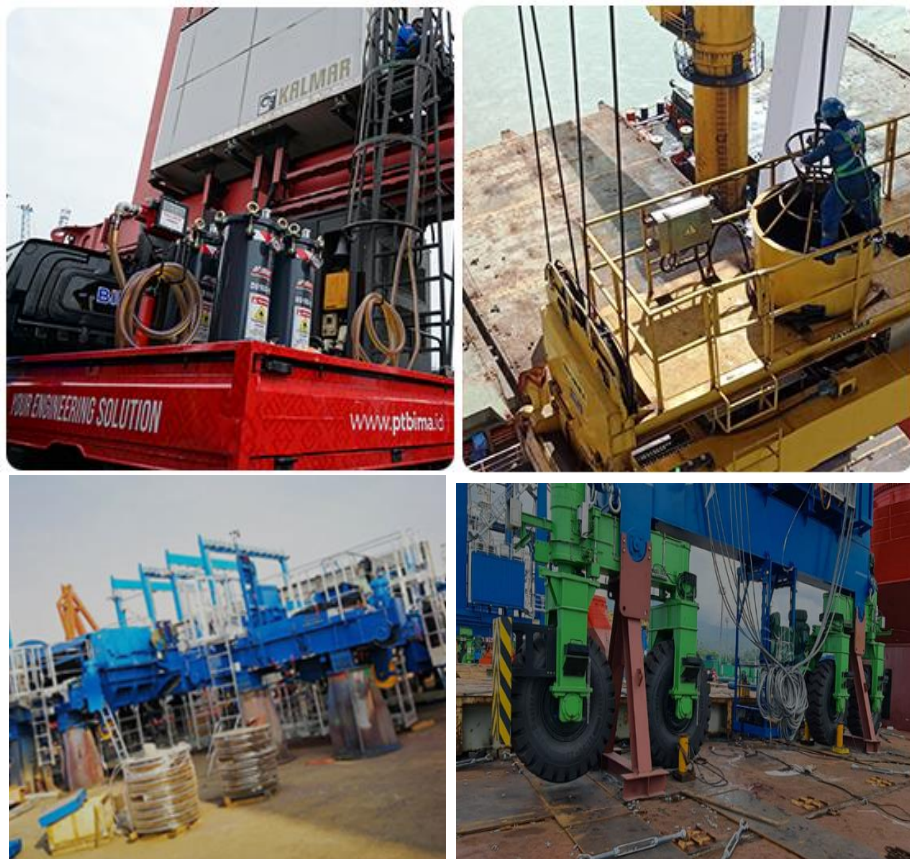
Gambar 2. 14 Kegiatan layanan peralatan Pelabuhan bidang mekanikal elektrikal
