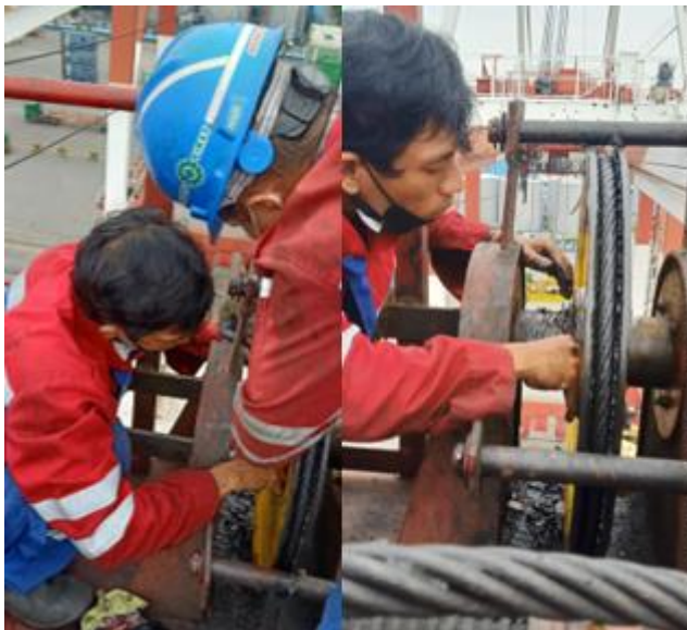
Perbaikan dan pemasangan Seal Roller Trolley bagian kanan pada Container Crane 01
