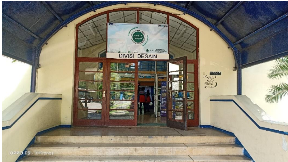
Gambar 4. 1 Gedung Divisi Desain
