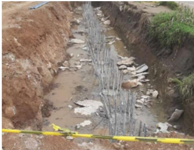
Gambar 3. 13 Area yang Akan Dilakukan Pekerjaan Perataan Permukaan
