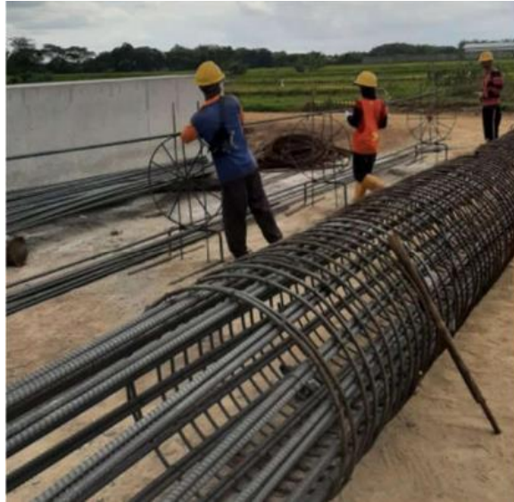
Gambar 3. 5 Pekerjaan Perakitan Tulangan
