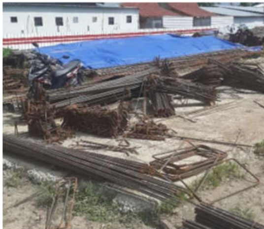
Gambar 3. 15 Area Pekerjaan Fabrikasi Tulangan
