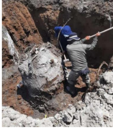
Gambar 3. 12 Pekerjaan Pembobokan Bored Pile
