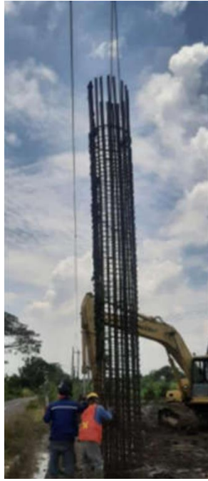
Gambar 3. 6 Pekerjaan Pemasangan Tulangan Bore Pile
