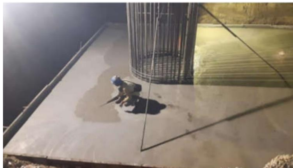
Gambar 3. 20 Pemerataan Hasil Pengecoran Ready Mix pada Pile Cap
