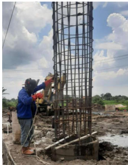
Gambar 3. 7 Pekerjaan Penyambungan Tulangan Bore Pile
