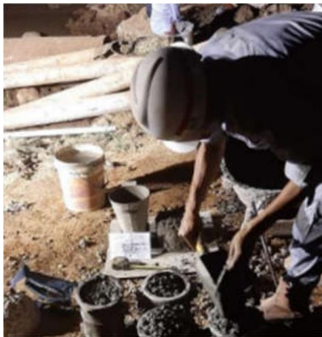
Gambar 3. 18 Pekerjaan Slump Test
