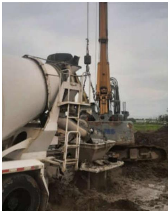
Gambar 3. 10 Pekerjaan Pengecoran Bore Pile
