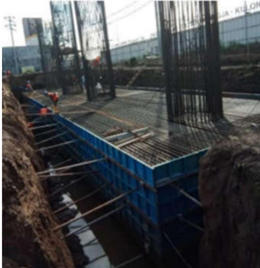
Gambar 3. 17 Pekerjaan Bekisting untuk Pile Cap
