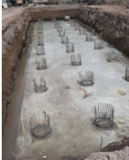
Gambar 3. 14 Pekerjaan Lantai Kerja
