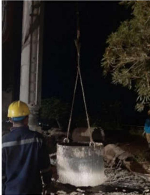
Gambar 3. 3 Pekerjaan Pemasangan Temporary Casing
