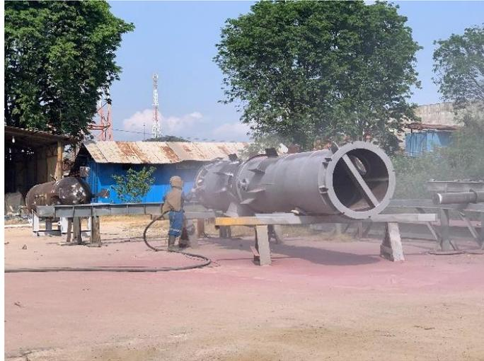
*Gambar 4. 9 proses sand blasting pada pressure vessel
