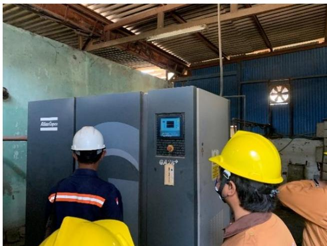
Gambar 4. 24 kompresor yang digunakan untuk sandblasting
