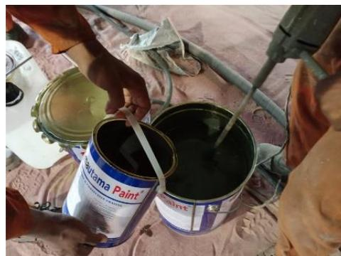
*Gambar 4. 28 proses pencampuran base dan harden (3:1)
