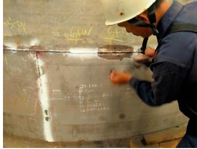
Gambar 4. 10 Proses Penetrant test ( Sumber : Dokumentasi Pribadi )
