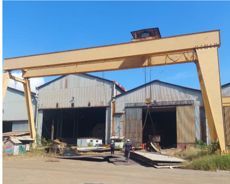
Gambar 4. 3 gudang penyimpanan material (sumber : dokumen pribadi)
