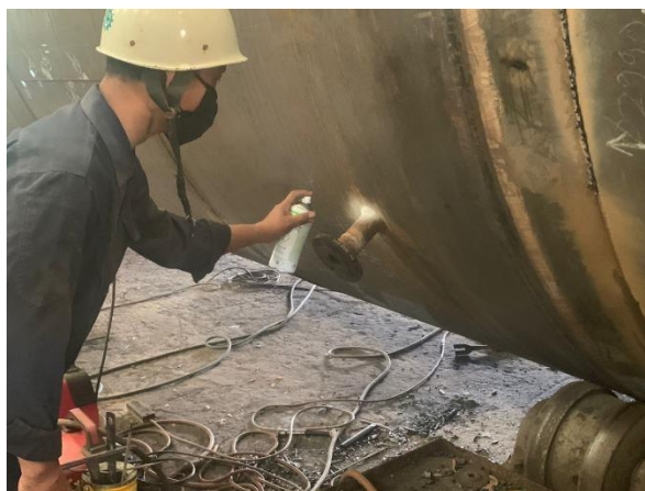
Gambar 4. 14 Proses Clean Surface ( Sumber : Dokumentasi Pribadi )
