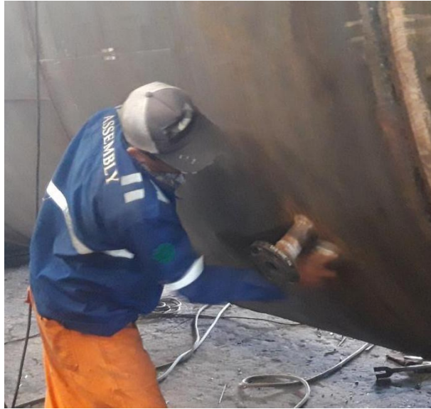
Gambar 4. 13 Proses Cleaning surface ( Sumber : Dokumentasi Pribadi )
