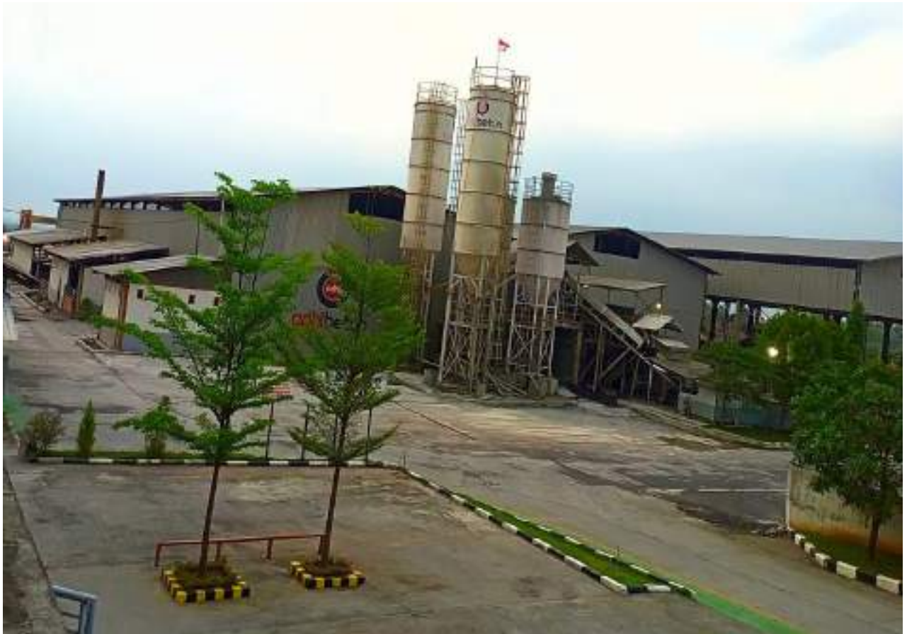
Gambar 2.14 Pabrik Timur PT. Adhi Persada Beton
