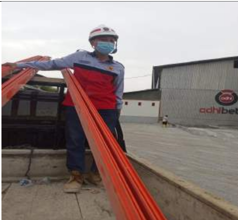
Pengangkutan Rel Semi Konduktor untuk Penggantian di Jalur Nol di PT Adhi Persada Beton
