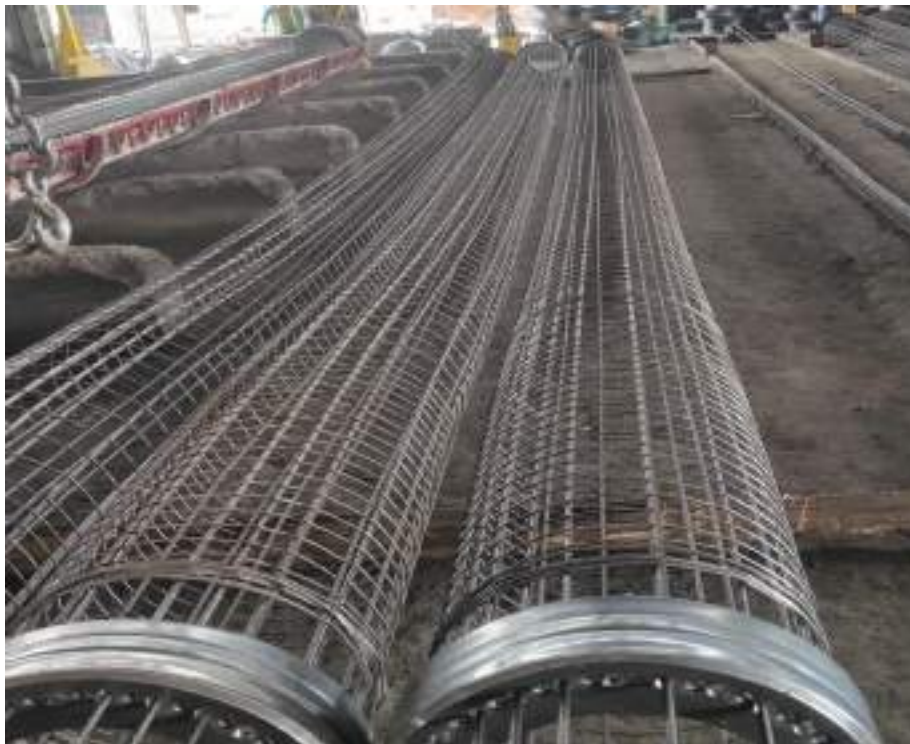
Gambar 4.1 Rangka Tiang Pancang
