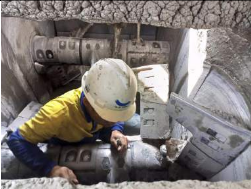
Membantu perbaikan Mixer Batching Plant di PT Adhi Persada Beton
