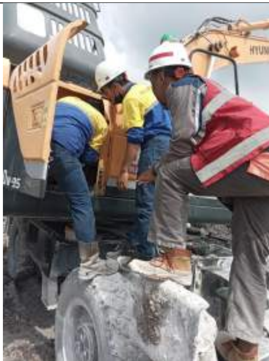
Perbaikan Excavator Wheel di PT Adhi Persada Beton akibat kerusakan pada Filter Bahan Bakar
