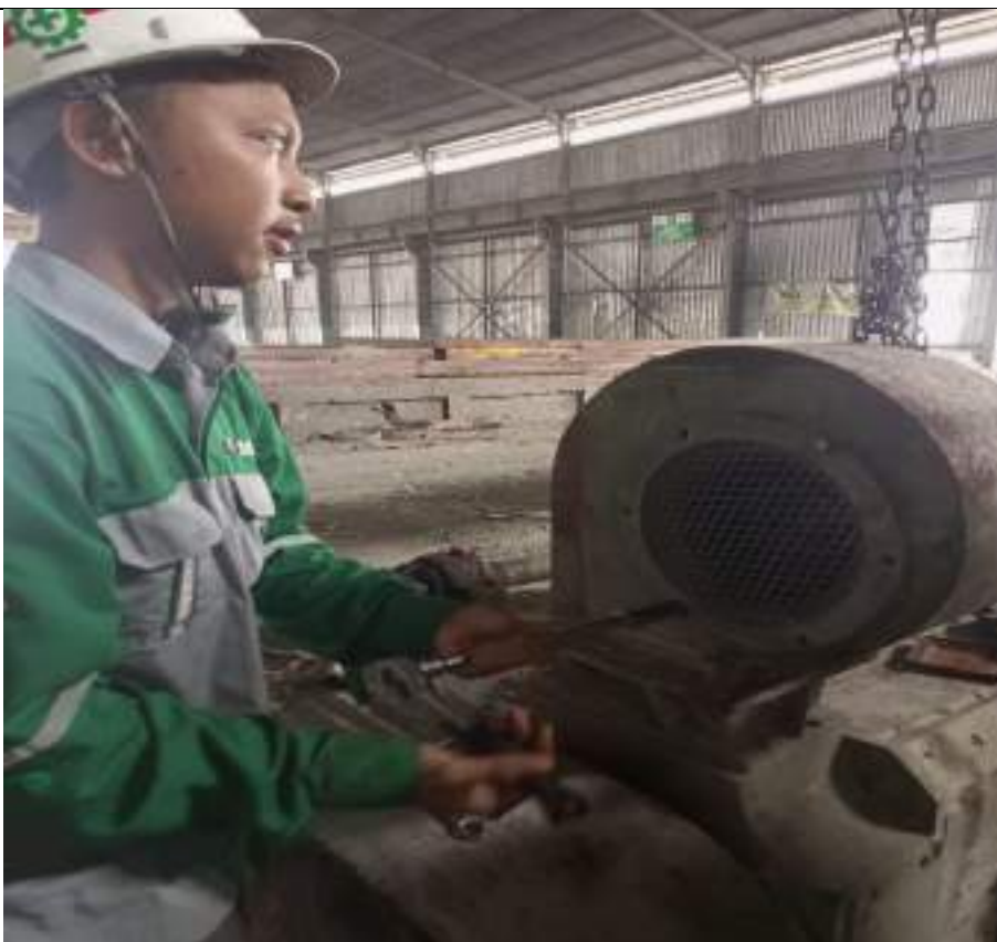
Memperbaiki Blower pada Mesin Spinning di PT Adhi Persada Beton
