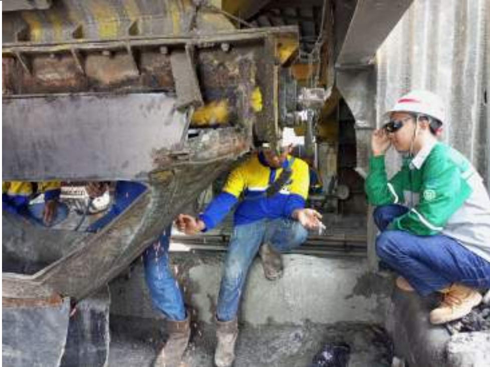
Perbaiki Screw pada Hopper Cor di PT Adhi Persada Beton
