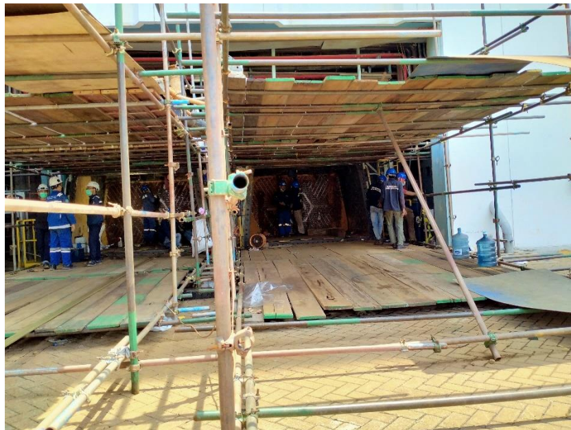
Gambar 4.45 Proses Re-Tubing Pada Saat Overhaul
