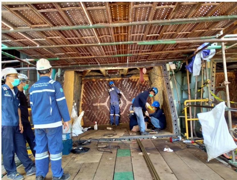
Gambar 4.47 Pengerjaan Re-tubing
