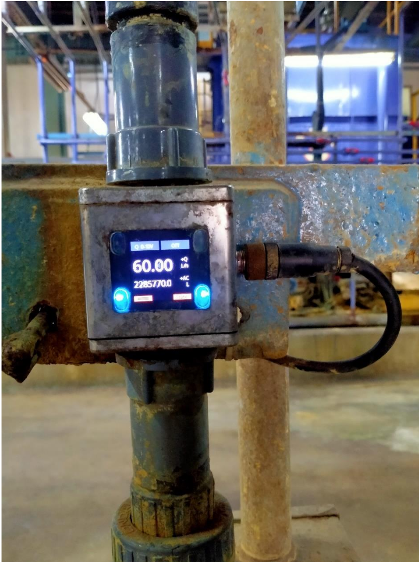
Gambar 4.31 Kadar Ferrous yang Sedang Diinjeksikan
