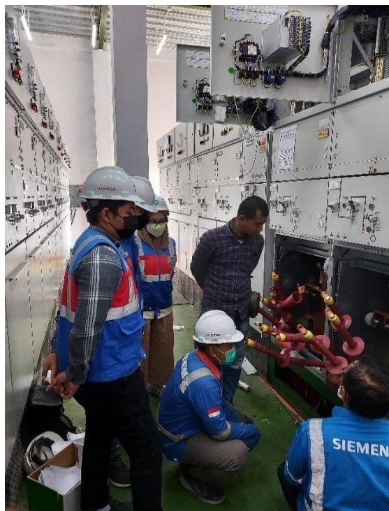
8. Pemasangan Cubicle pada HVS 3
