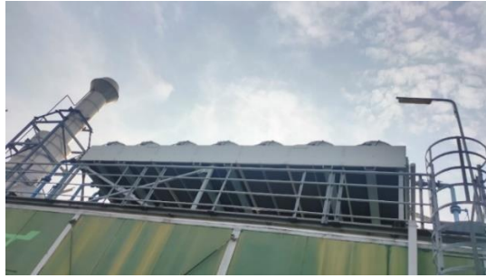
Gambar 4.16 Fan Radiator
