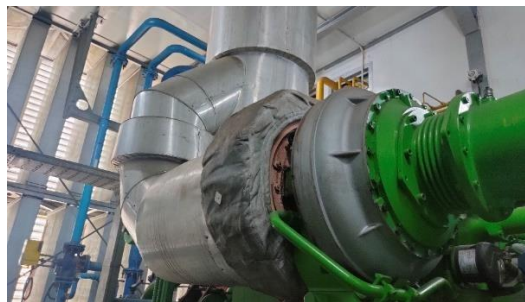
Gambar 4.2 Konstruksi Turbocharger
