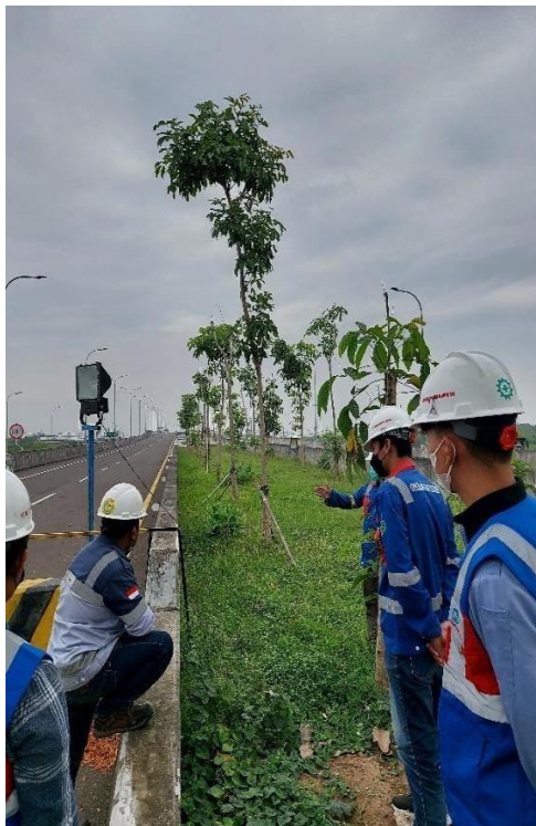
7. Pengecekan Pemasangan Kabel Tol
